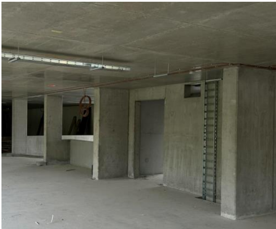
Obr. 38: Terén - pohľad na skúšanú časť.
