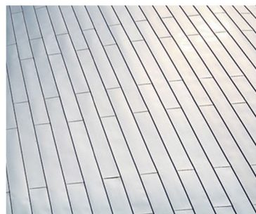
Titanzinkový plech opláštění střechy chrámové lodi
