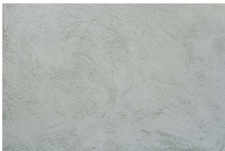
Omítka imitující beton exteriérové plochy obvodových stěn
