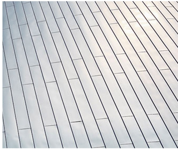
Titanzinkový plech opláštění střechy chrámové lodi
