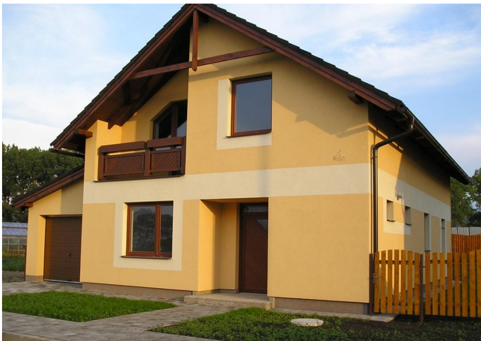
Obr. 4 - Pohľad čelný – uličný [Vlastný]
