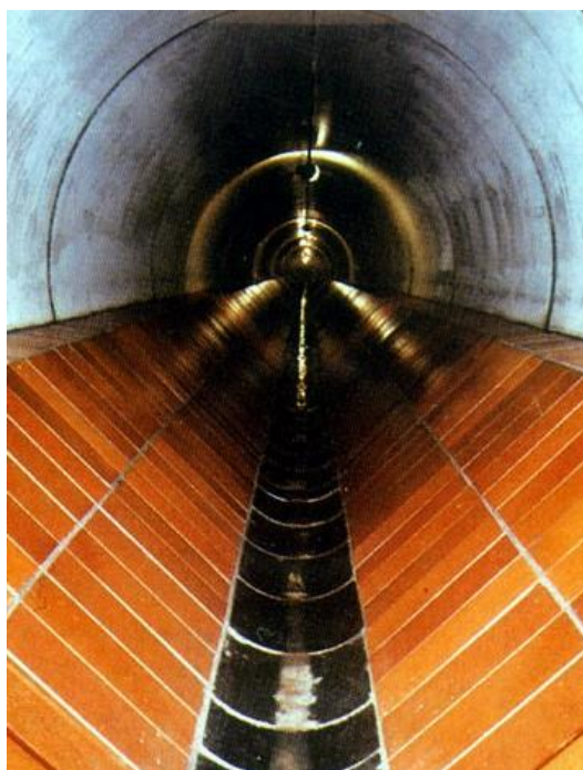
Obr. 3.4. Příklad výstelky z kameninových dlaždic [5]
