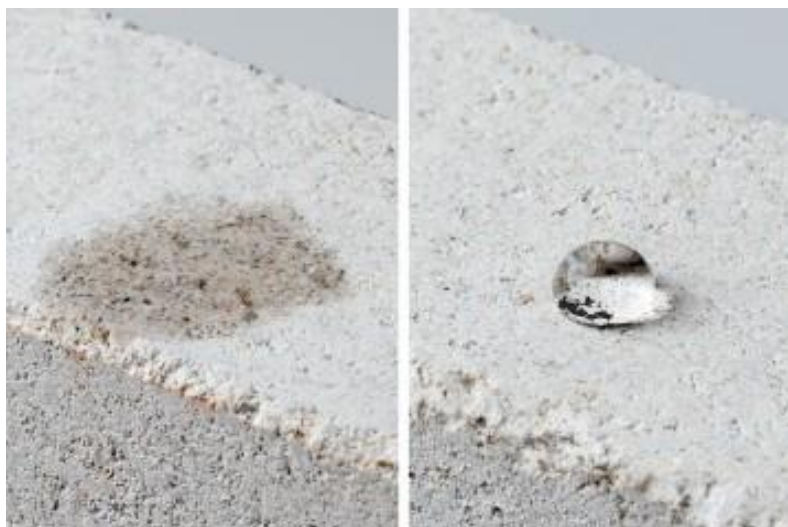
Obr. 5.3. Vlevo – beton bez ošetření; vpravo – beton ošetřený impregnací [31]
