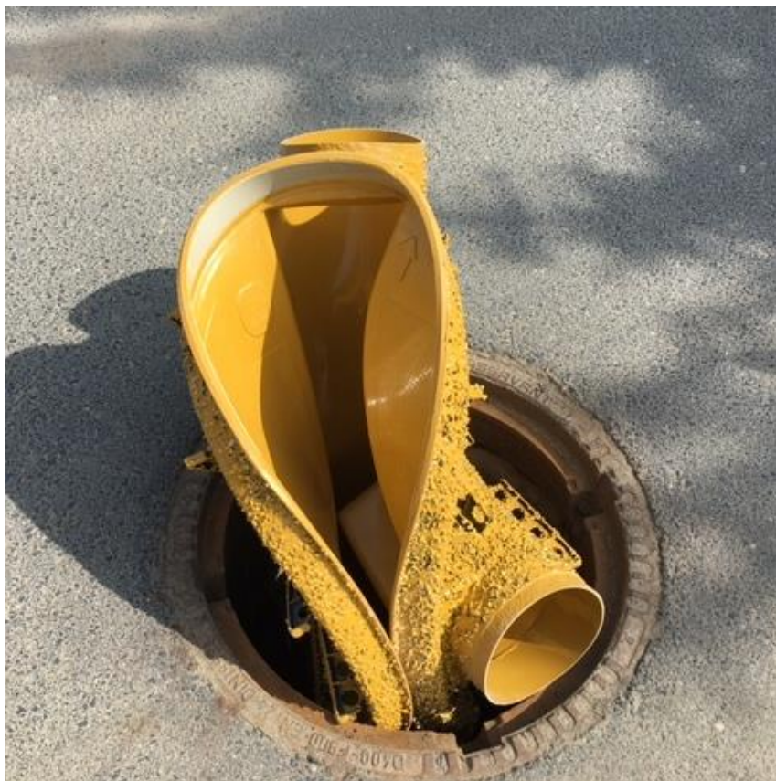
Obr. 6.1. Plastová vložka dna Flexliner [34]
