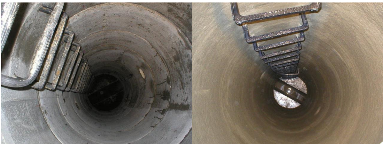
Obr. 6.4. Vlevo – šachta před nástřikem; vpravo – dokončená sanace šachty [38]
