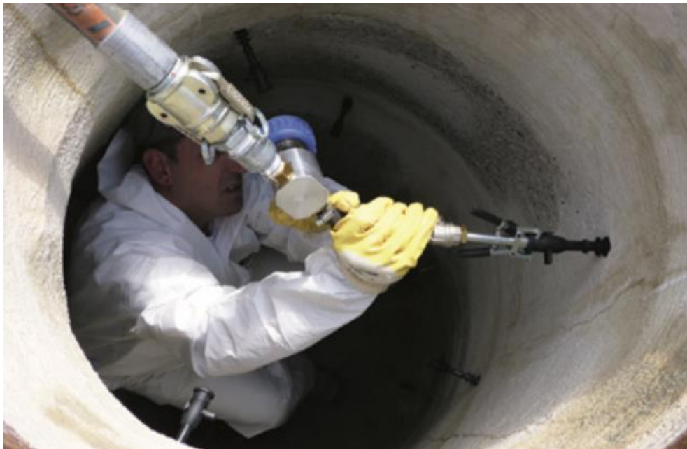
Obr. 5.4. Pracovník provádějící injektáž cementové směsí za ostění trouby [32]
