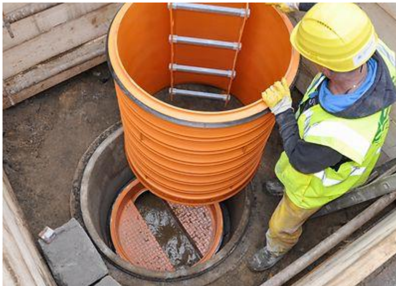
Obr. 6.2. Instalace plastové šachty do stávající betonové šachty [42]
