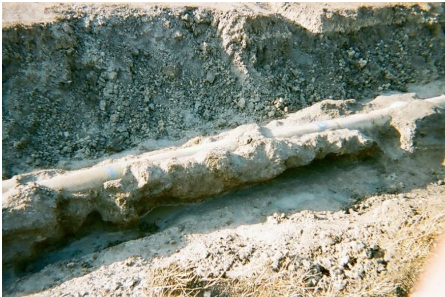
Obr. 4.4. Výsledek zátopové injektáže z vnější strany [15]
