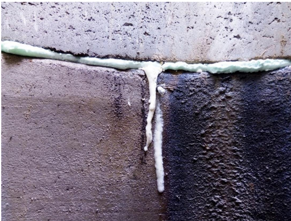
Obr. 6.6. Detail zainjektovaného spoje [40]
