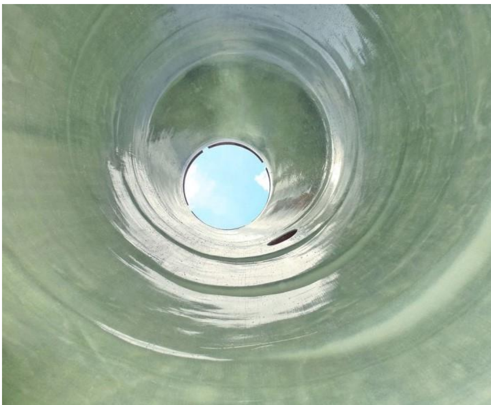
Obr. 6.5. Pohled ze dna šachty na povrch sanované šachty rukávцем [44]
