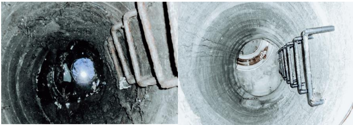
Obr. 6.7. Vlevo – šachta před nanesením stěrky; vpravo – dokončená stěrka [41]
