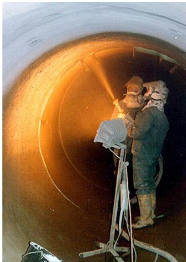
Obr. 5.5. Provádění mokrého nástřiku betonového ostění [5]
