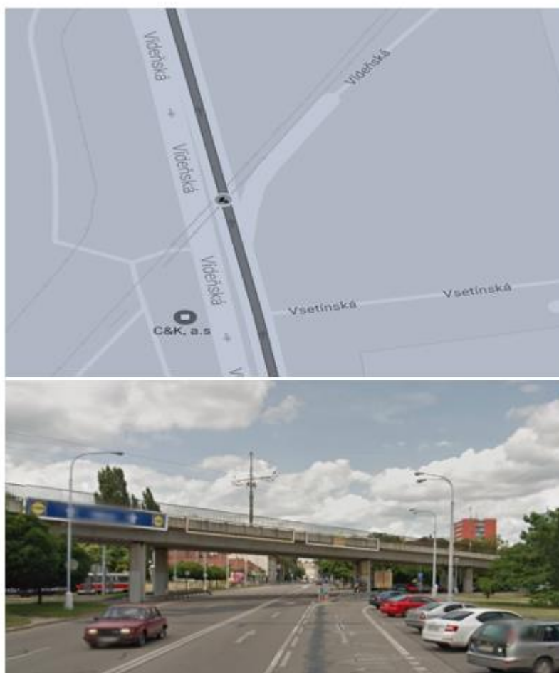
Obr. 46 Podjezd na ulici Vídeňská
