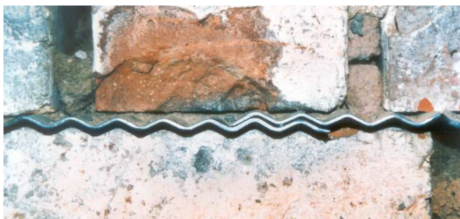
Obr. 11 : Nerezové plechy s překrytím o dvě vlny [12]
