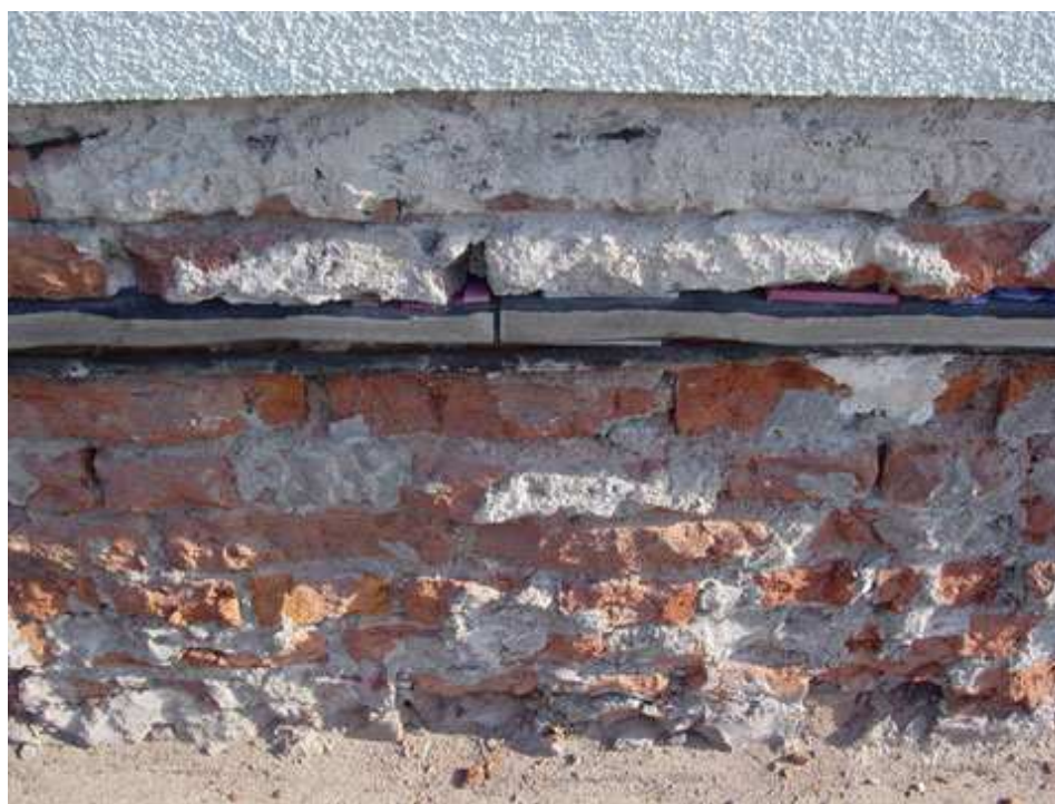
Obr. 8 : Fólie přesah 100 mm [14]
