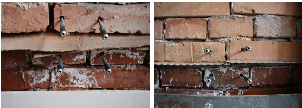
Obr. 25 : Umístění měřících bodů nad spoji hydroizolací
