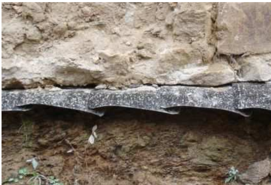
Obr. 9 : Fólie přesah 50 mm [15]
