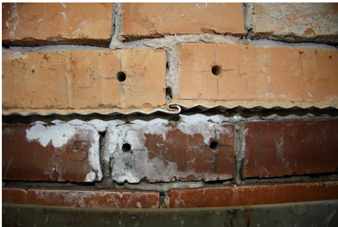
Obr. 17 : Nerezové plechy – spoj pomocí zámku
