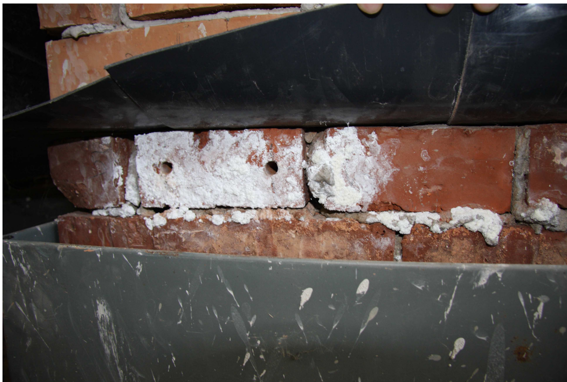
Obr. 18 : LDPE fólie – přesah pásů 50 mm
