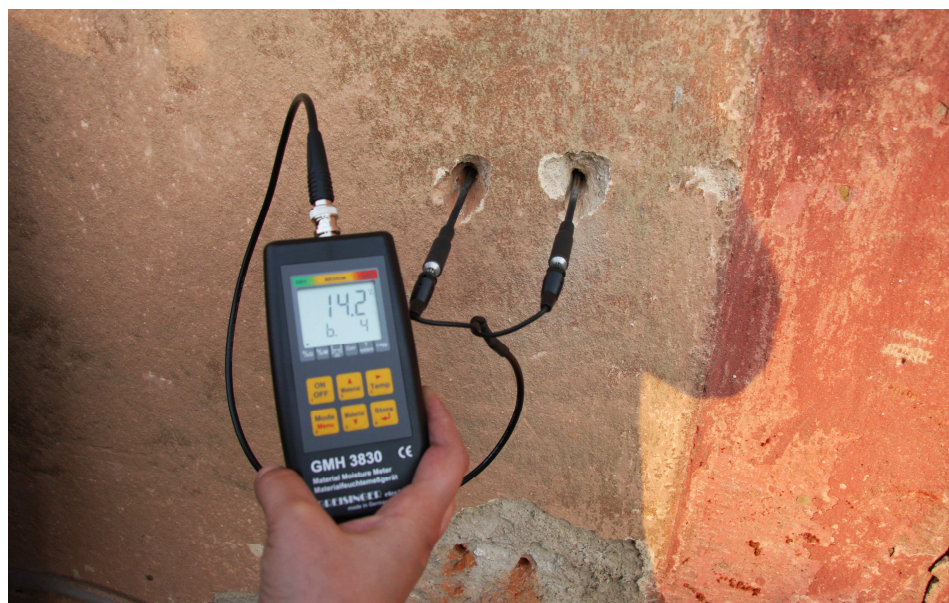
Obr. 49 : Průběh měření na objektu rodinný dům Opava – měřící bod 3
