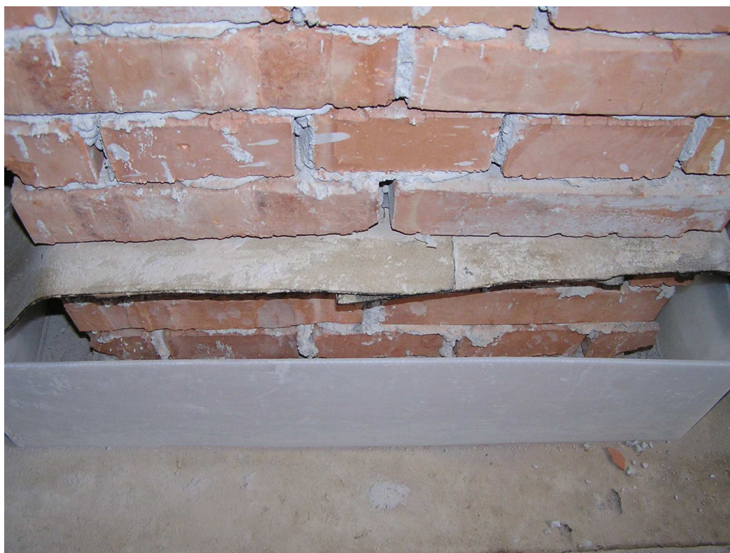
Obr. 19 : Asfaltové pásy – přesah pásů 100 mm
