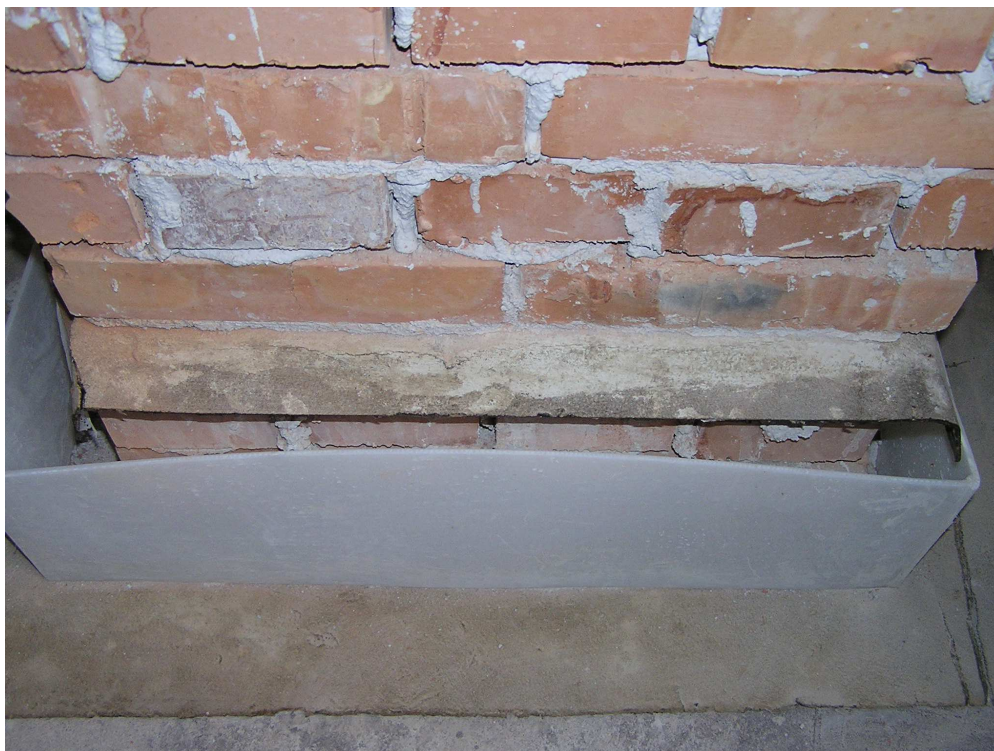
Obr. 20 : Asfaltový pás vcelku
