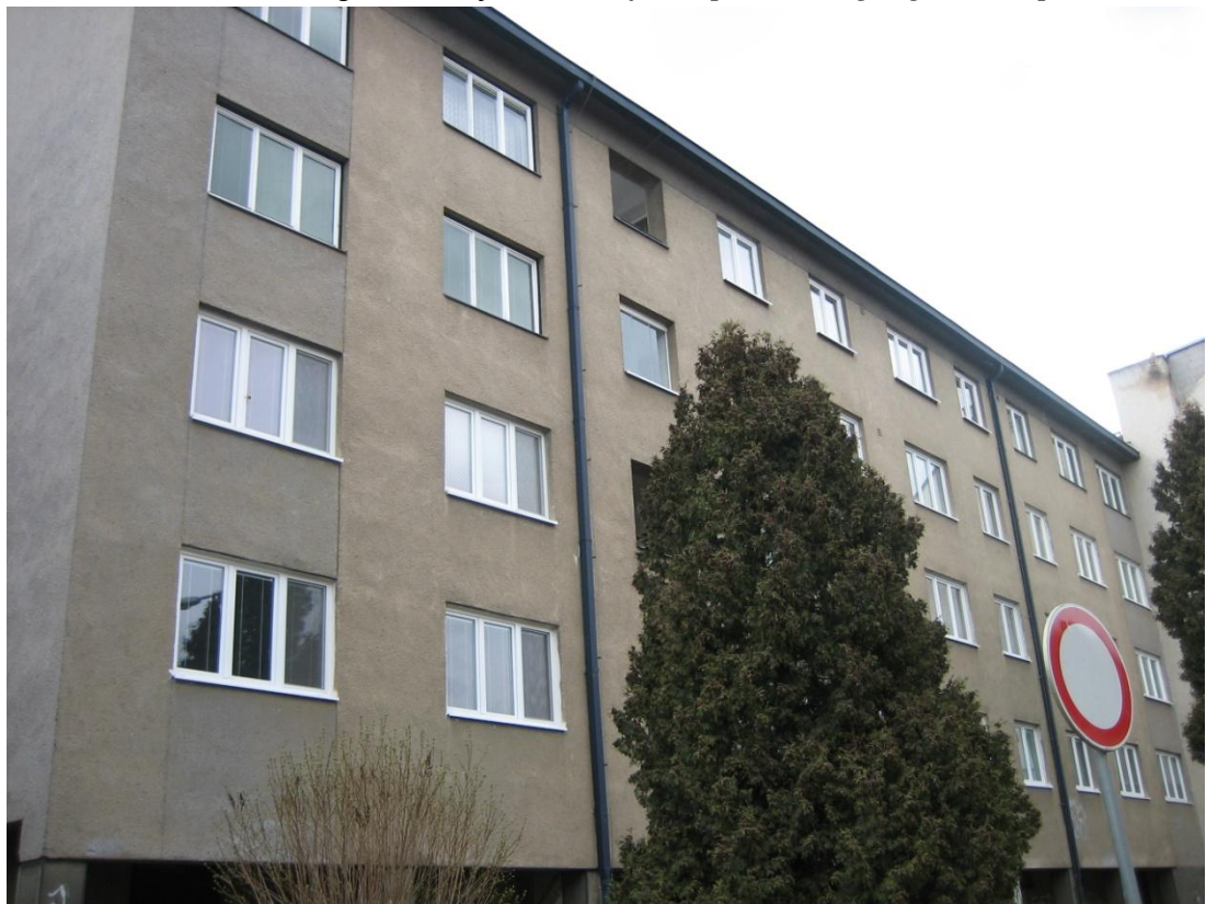
Obr.č. 6: Čelní pohled na objekt SV. zdroj:[autor]
