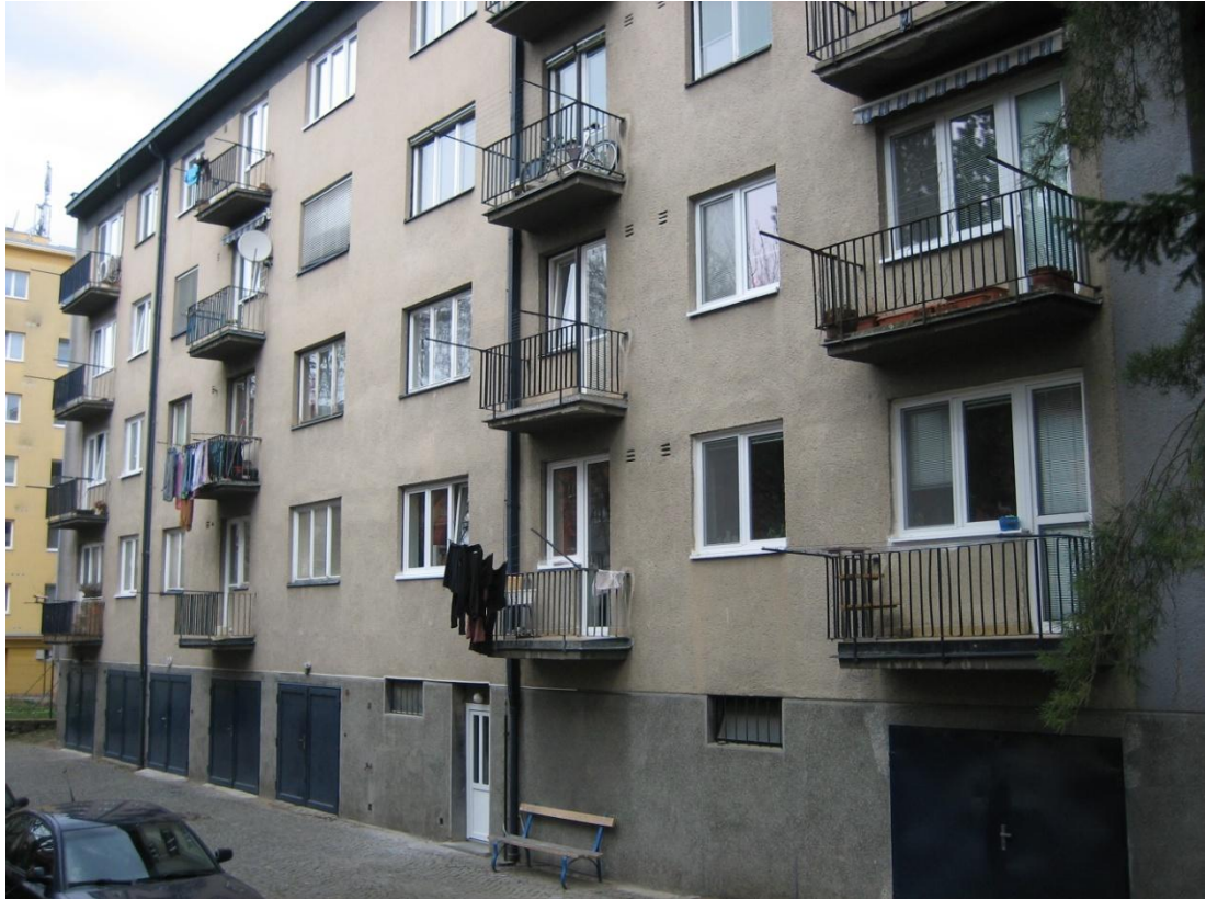
Obr.č. 7: Zadní pohled na objekt JZ. zdroj: [autor]
