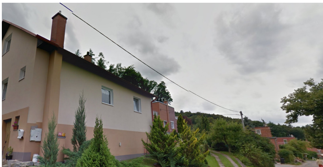
Obrázek 20 - RD se sedlovou střechou v kontinuální zástavbě „Půldomků“ (zdroj: vlastní zpracování)
