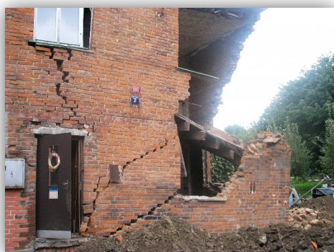
Obrázek 25-26 - Snímky pořízené v r. 2028 po dlouhotrvajících deštích, které poškodili velkou řadu nemovitostí (zdroj: fiktivní archiv fotografií města Zlína)
