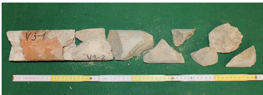
Obrázek 41 - jádrový vývrt V3
