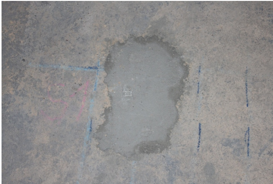
Obrázek 20 - Zapravená sonda S1 s možností opětovného použití kamery
