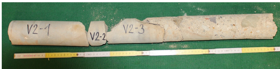
Obrázek 44 - Jádrový vývrt V2
