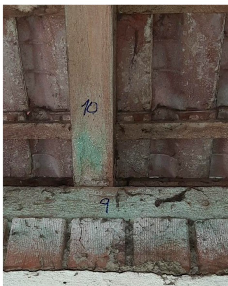
Obrázek 33 – Pozednice sonda D9 a D10 [13]
