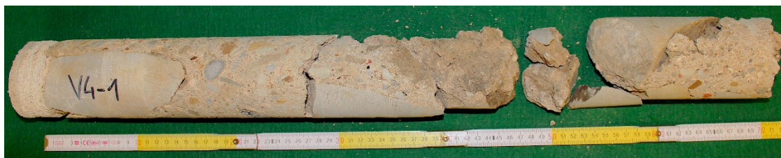
Obrázek 48 - Jádrový vývrt V4
