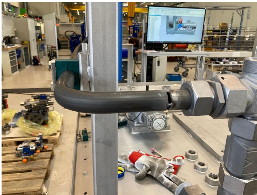
Obr. 29 Příprava montážního svaru na agregátu.
