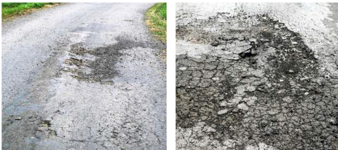
Obrázek č. 51 a 52 – Porucha netuhé vozovky dle TP 82 – Prolomení vozovky. Zdroj: TP 82 168
