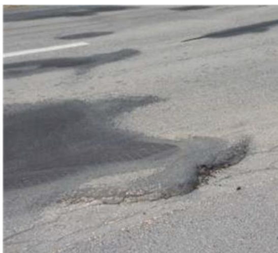
Obrázek č. 39 a 40 – Porucha netuhé vozovky dle TP 82 – Nepravidelné hrboly. Zdroj: TP 82 162
