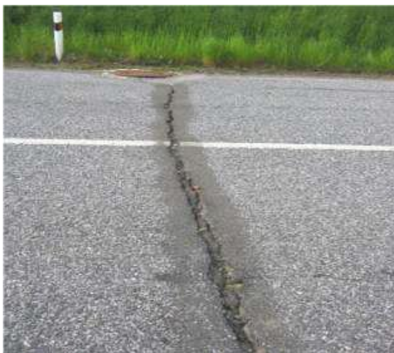
Obrázek č. 31 a 32 – Porucha netuhé vozovky dle TP 82 – Příčná trhlina. Zdroj: TP 82 158
