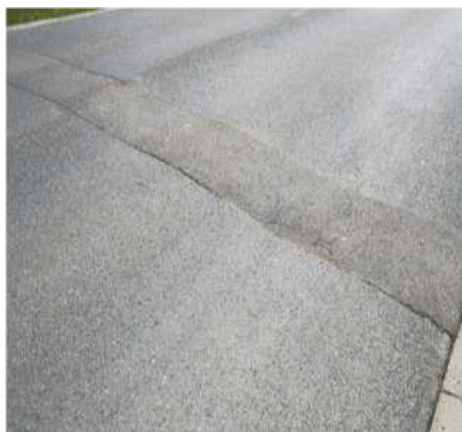
Obrázek č. 45 a 46 – Porucha netuhé vozovky dle TP 82 – Podélné poklesy. Zdroj: TP 82 165
