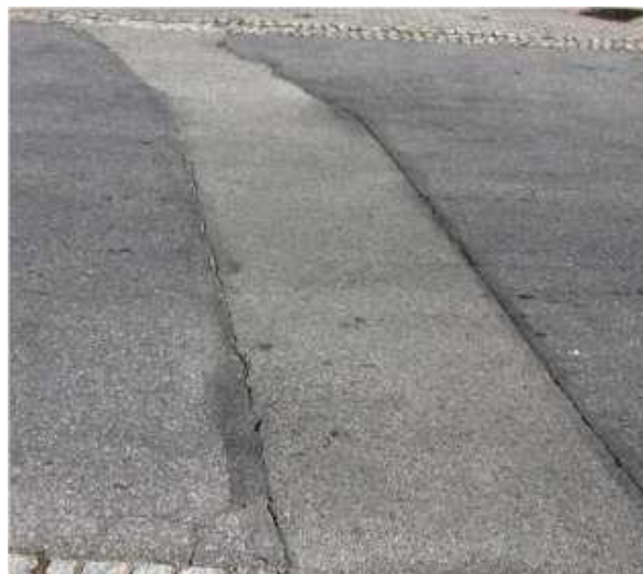
Obrázek č. 45 a 46 – Porucha netuhé vozovky dle TP 82 – Podélné poklesy. Zdroj: TP 82 165
