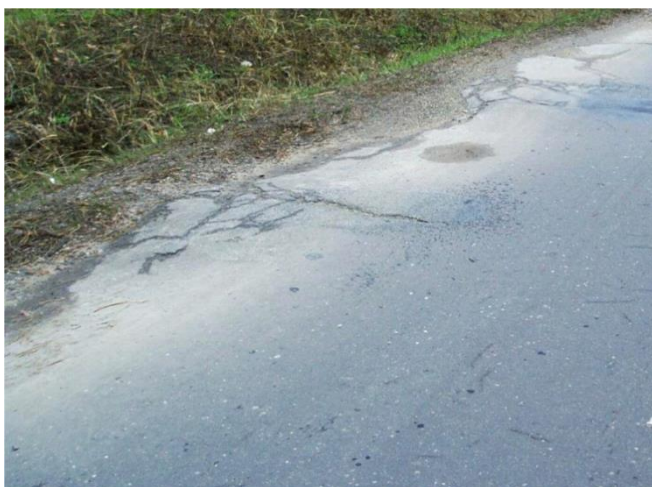
Obrázek č. 41 a 42 – Porucha netuhé vozovky dle TP 82 – Místní hrboly. Zdroj: TP 82 163
