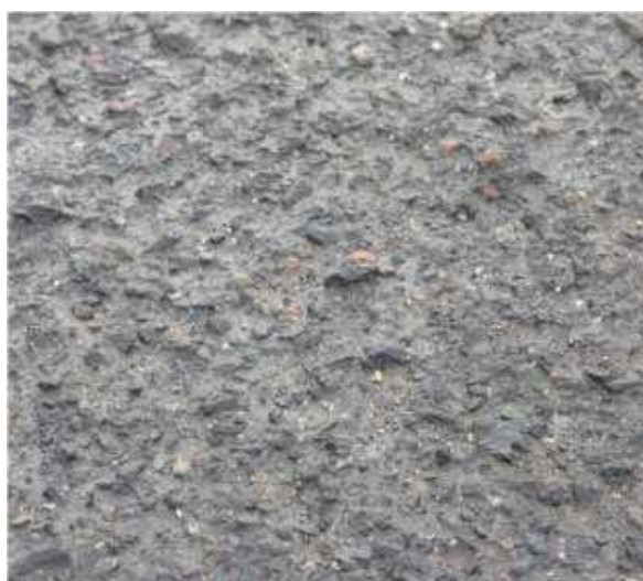
Obrázek č. 22 a 23 – Porucha netuhé vozovky dle TP 82 – Hlubková koroze. Zdroj: TP 82 153
