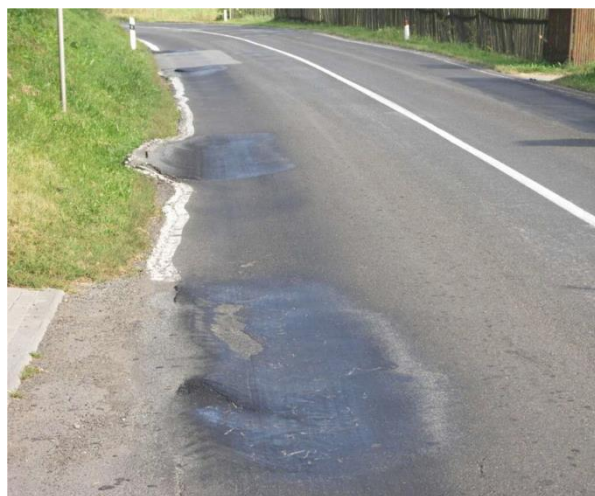
Obrázek č. 41 a 42 – Porucha netuhé vozovky dle TP 82 – Místní hrboly. Zdroj: TP 82 163
