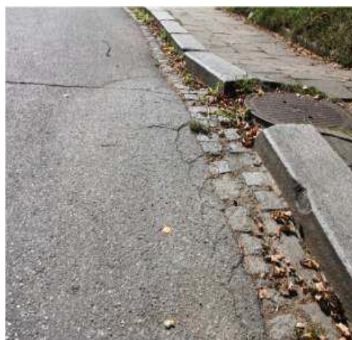
Obrázek č. 39 a 40 – Porucha netuhé vozovky dle TP 82 – Nepravidelné hrboly. Zdroj: TP 82 162
