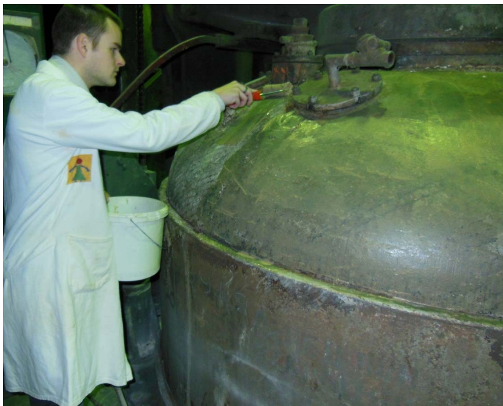
Obr. 22: Snímek zachycuje primární nátěr ocelového povrchu formátoru pneumatik po sejmutí staré izolace a před nanesením tepelně izolační vrstvy.
