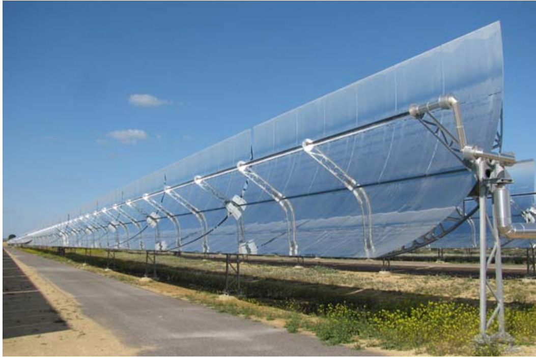
Obr. 8: Zrcadla směřující sluneční záření do jednotného ohniska, kde dochází k ohřátí média.
