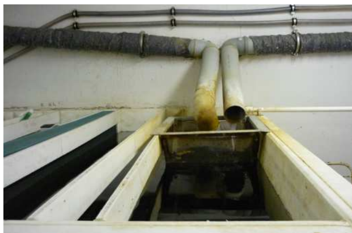
Obrázek č. 20: Pohled shora na část čistící nádrže s přítoky vody z akvaterárií
