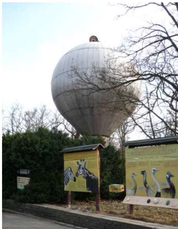
Obrázek č 3: Vodojem pro užitkovou vodu
