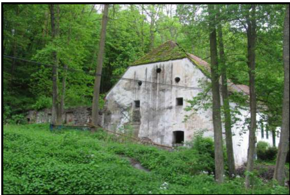
Obrázek č. 18 – Bývalá provozní budova mlýna snímek 2
