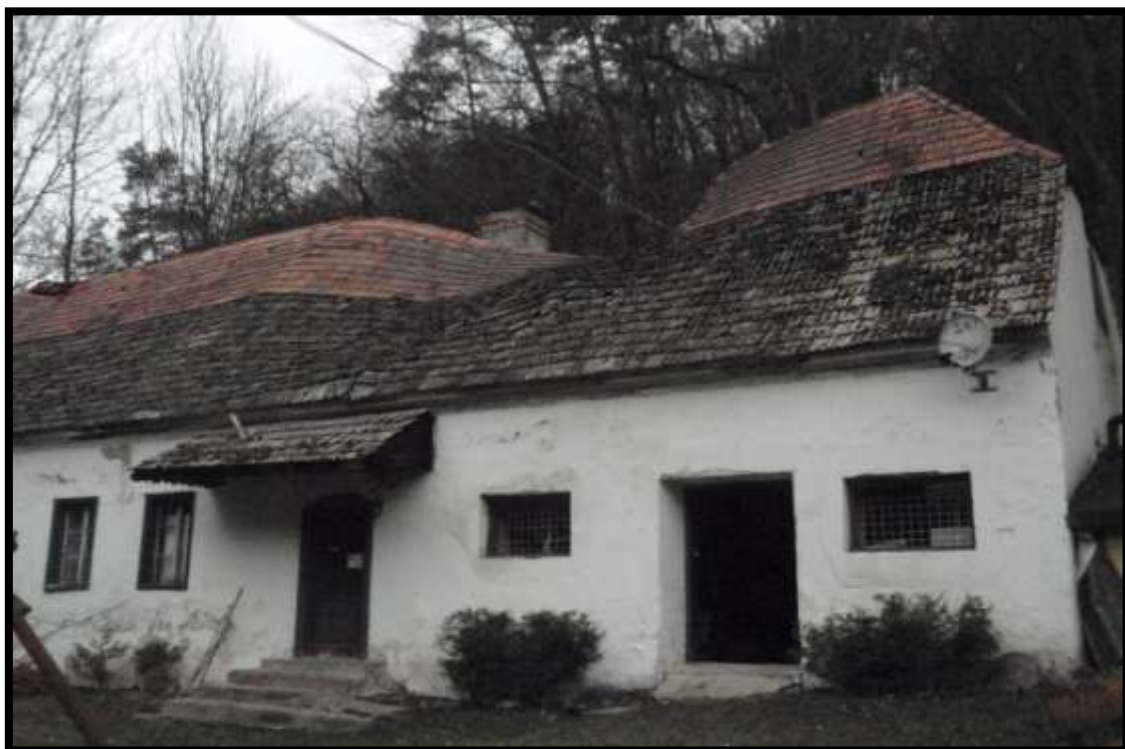
Obrázek č. 17 – Bývalá provozní budova mlýna snímek 1
