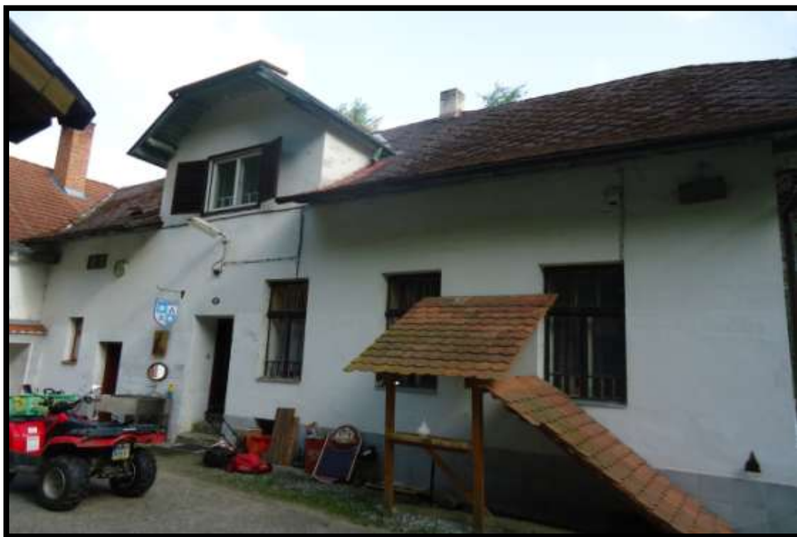
Obrázek č. 13 – Hlavní budova Peksova mlýna snímek 3
