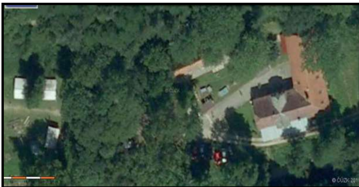
Obrázek č. 9 – Letecký snímek hlavní budovy
