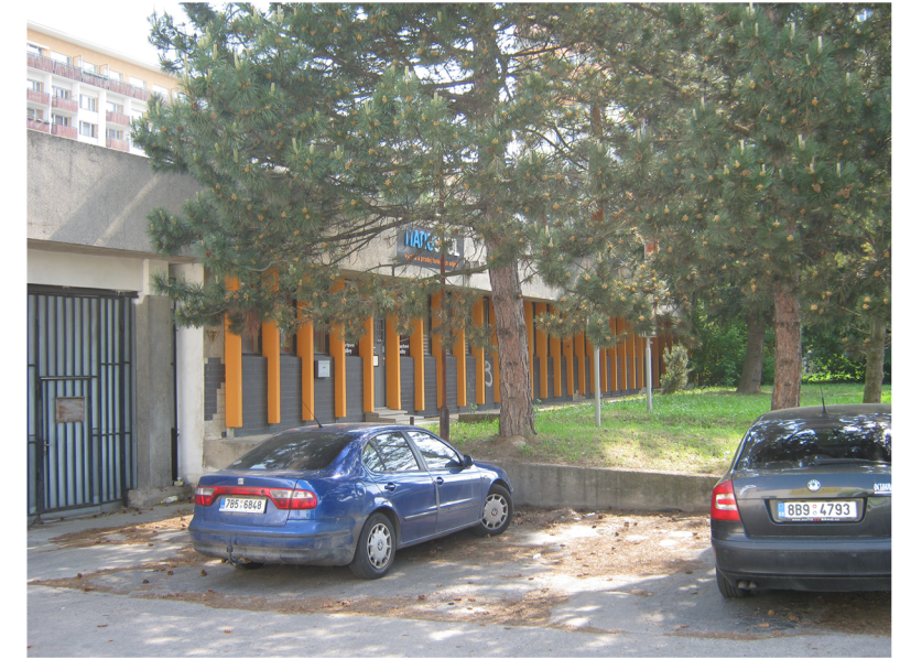
VÝMĚNIKOVÁ STANICE; VEDLE FIRMA NANOSPOL
