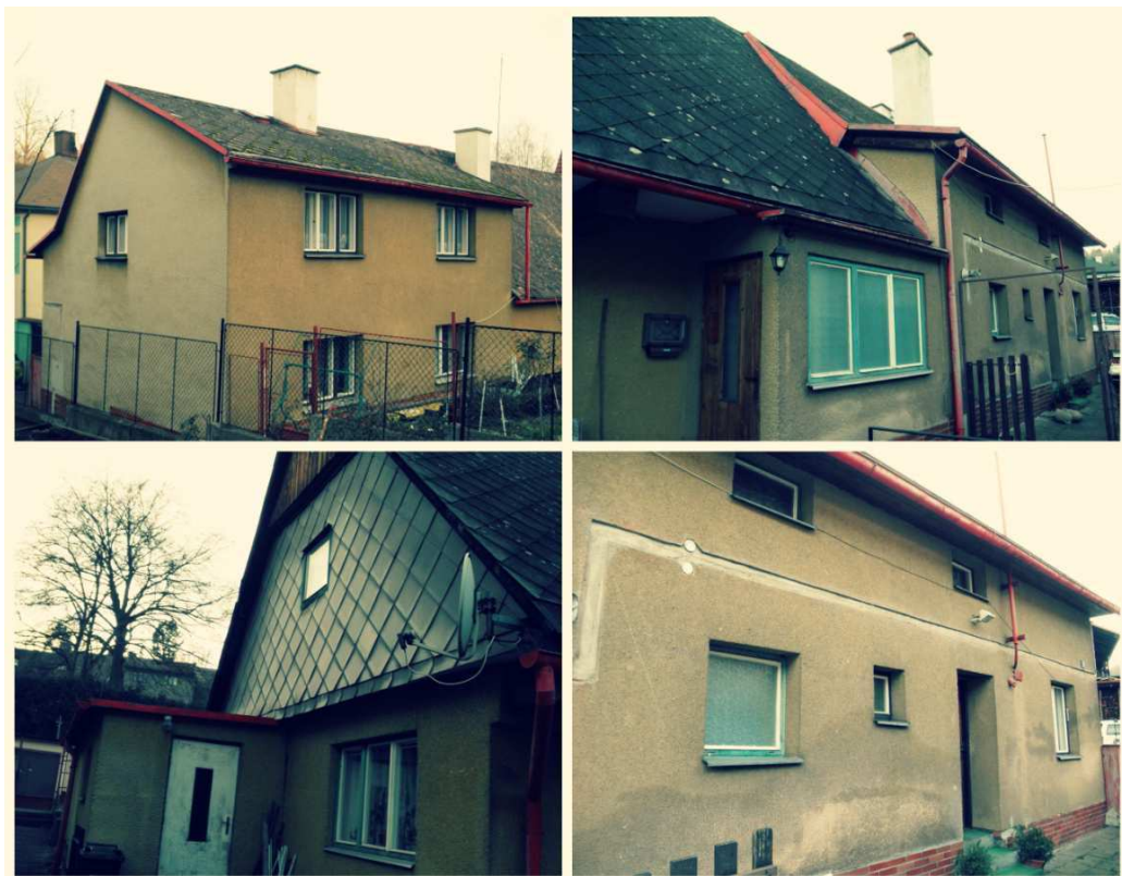
Obr. 8.3: Další fotodokumentace rodinného domu
