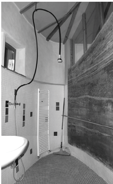
Obrázek 7: Dusaná stěna v koupelně, víkendový dům, Německo. Foto: I. Žabičková; Obrázek 8: Detail dusané stěny, víkendový dům, Německo. Foto: I. Žabičková
