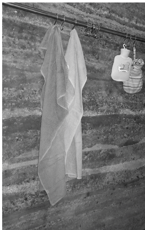
Obrázek 7: Dusaná stěna v koupelně, víkendový dům, Německo. Foto: I. Žabičková; Obrázek 8: Detail dusané stěny, víkendový dům, Německo. Foto: I. Žabičková
