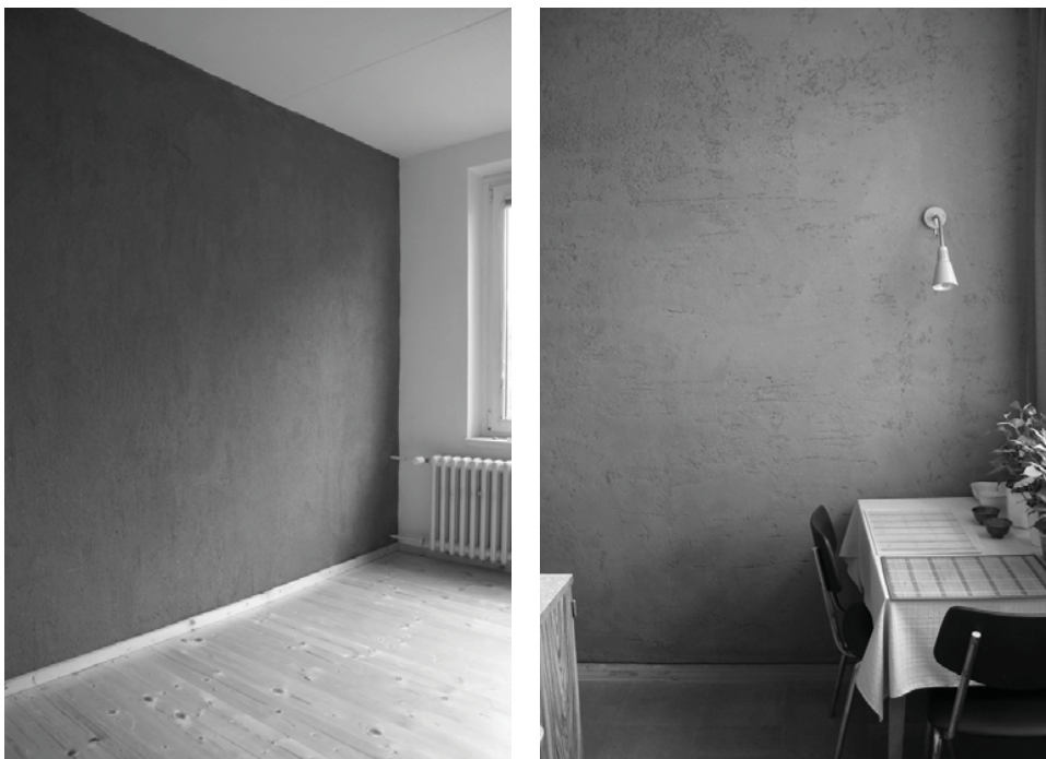
Obrázek 1: Hrubá hliněná omítka v pracovně bytu v panelovém domě. Foto: T.Mošťák, Obrázek 2: Hrubá hliněná omítka v kuchyni bytu v panelovém domě Foto: Archiv autora
