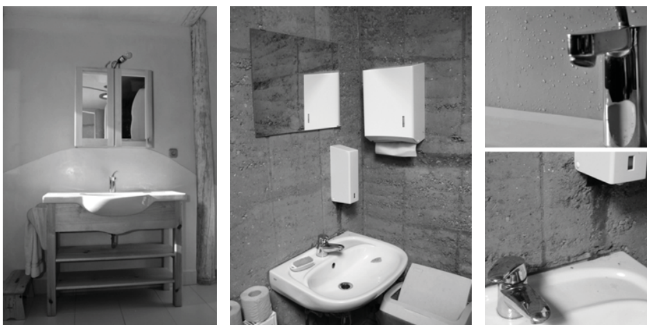
Obrázek 3: (vlevo) Hliněná omítka v koupelně rodinného domu a ošetření plochy za umyvadlem variantou marockého štku [3]; Obrázek 4: (uprostřed) Dusaná stěna na toaletách v kulturním domě, Wangelin, Německo; Obrázek 5: (vpravo nahoře) Detail hliněného povrchu z obr. 3 [3]; Obrázek 6: (vpravo dole) Detail hliněného povrchu z obr. 4. Foto: Archiv autora
