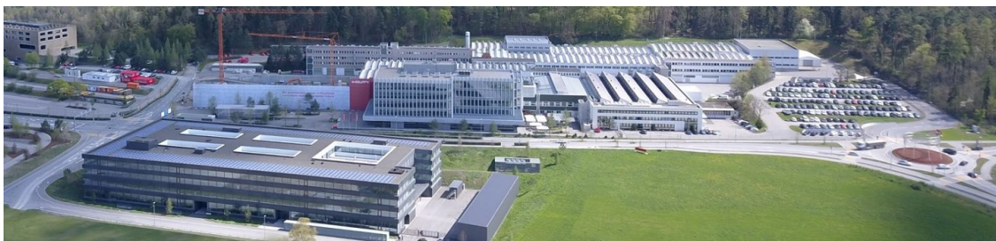
Obr. 3.2: Snímka výrobného závodu P1 spoločnosti Hilti v Lichtenštajnsku
