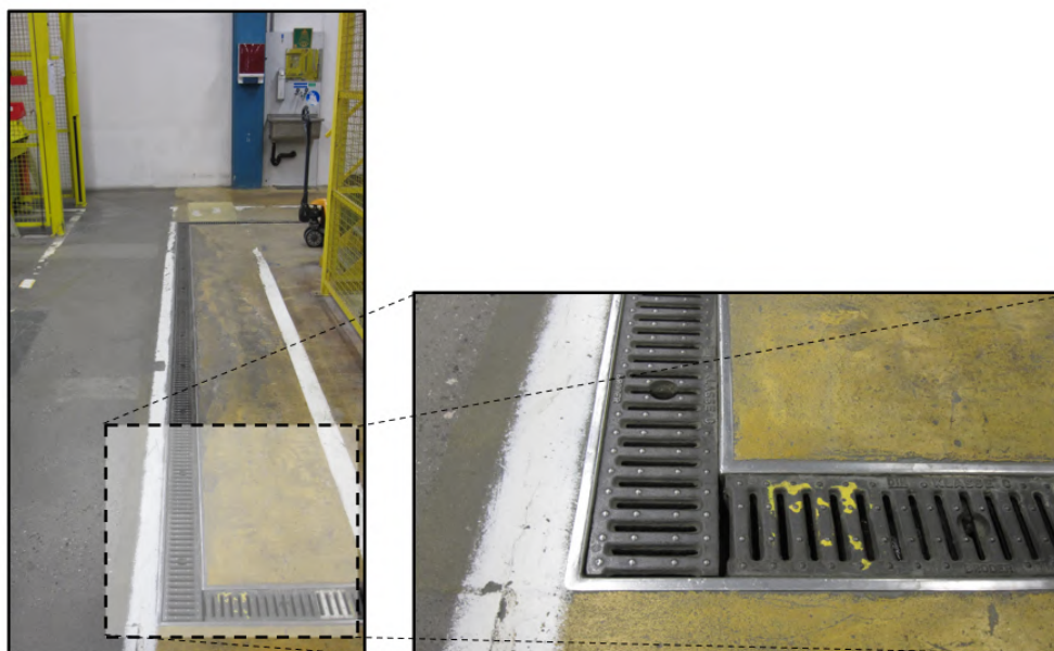
Obr. 4.20: Poklop pre zakrytie šachty z kompozitného materiálu[33]
