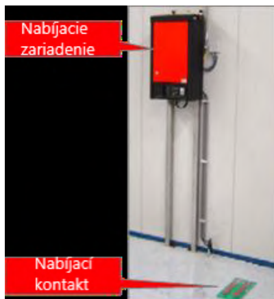
Obr. 4.4: Zobrazenie umiestnenia nabíjacej stanice spolu s nabíjacím kontaktom umiestneným v podlahe (zdroj: Dematic)
