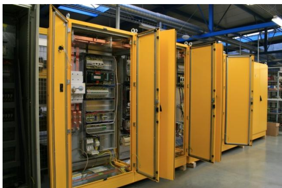
Obr. 5: Rozváděče a ovládací pulty
