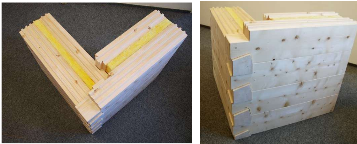
Obr. 6: Sendvičová roubená konstrukce. Převzato z [92].
