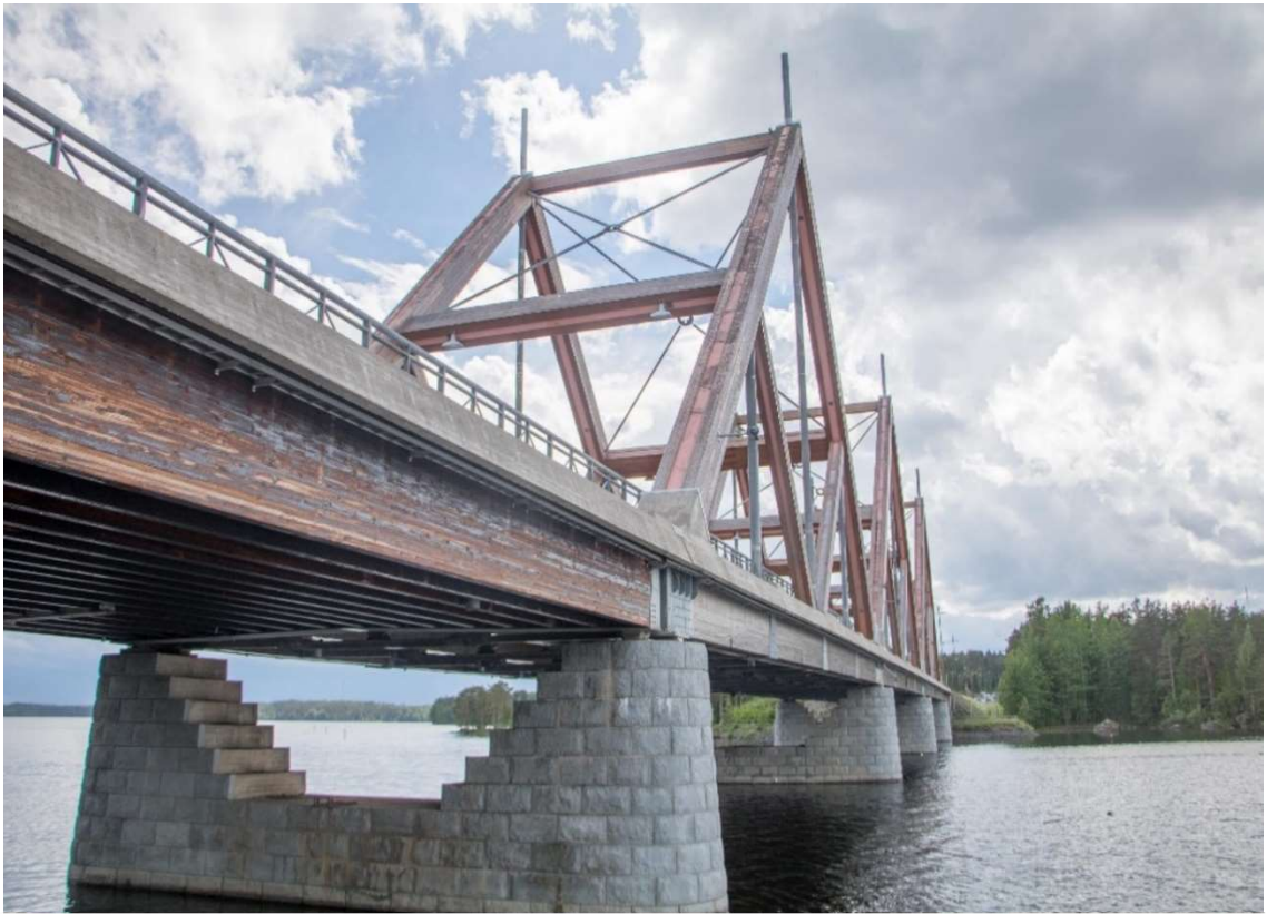
Obr. 85: Pohled na most.
