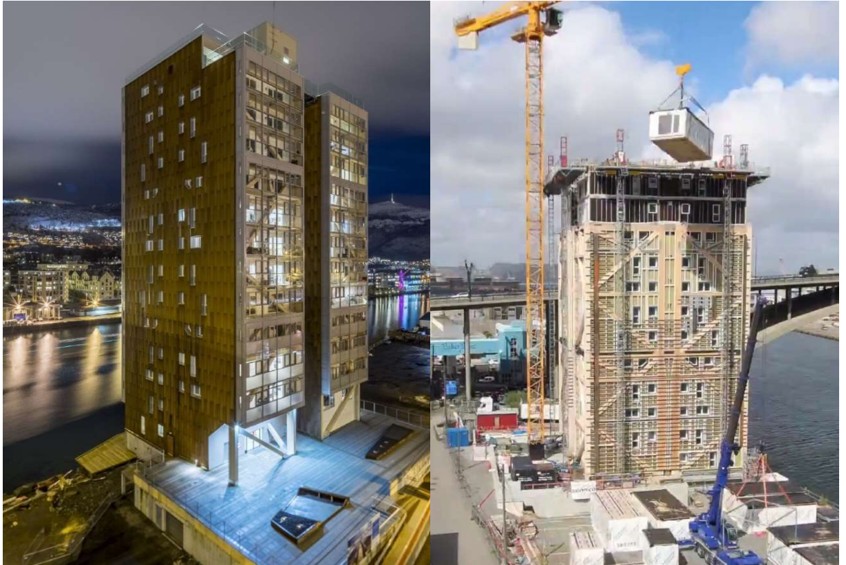
Obr. 7: Nejvyšší dřevěný bytový dům na světě k roku 2017, Bergen Norsko. Převzato z [40].
