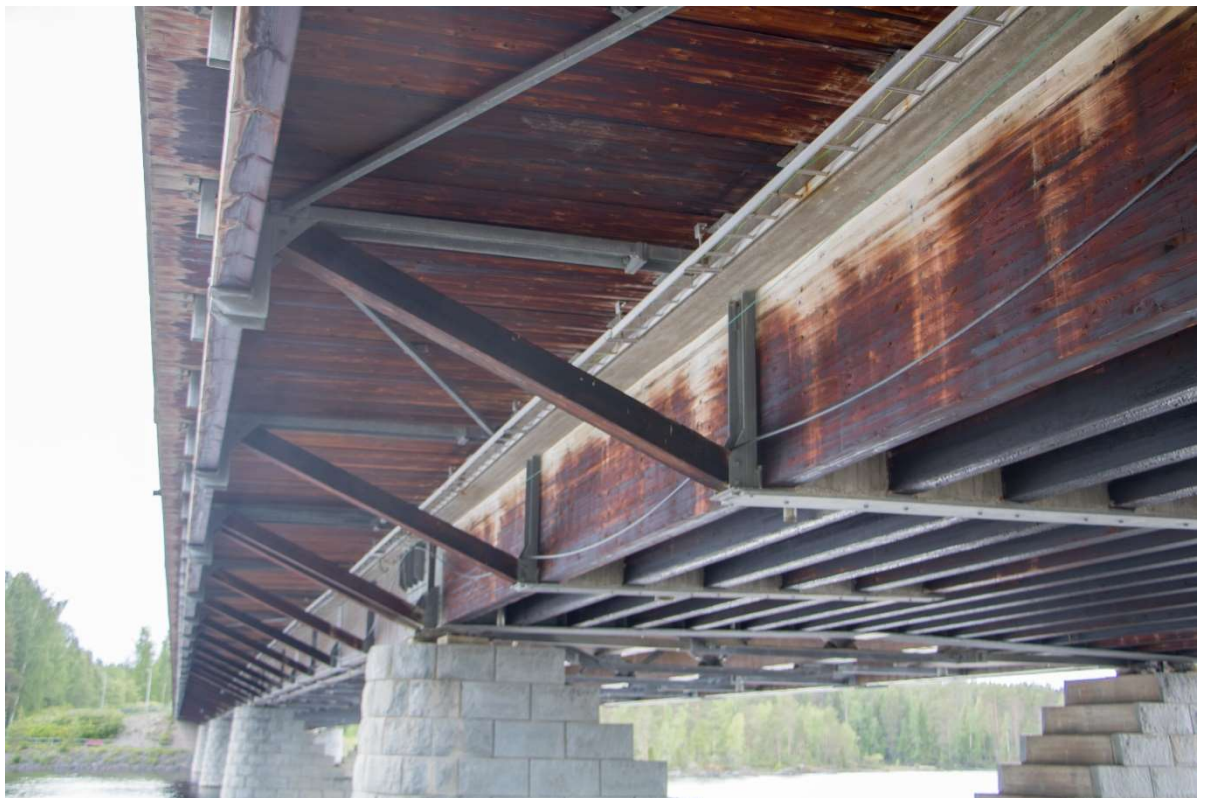
Obr. 87: Pohled na lepené lamelové nosníky mostu.
