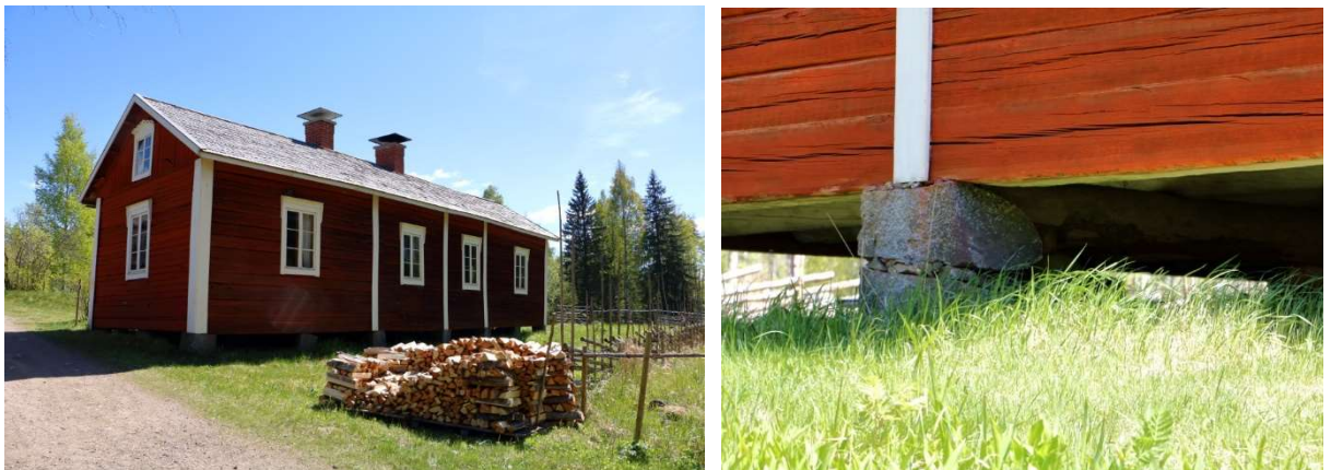
Obr. 3: Dřevostavba na kamenných pilířích ve Finsku. Zdroj autor.
