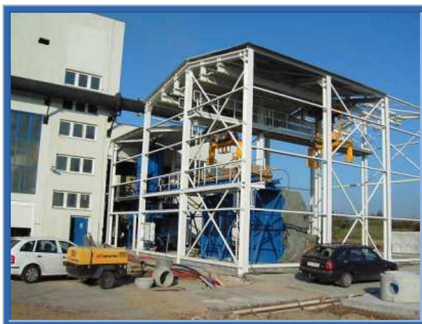
Obr. 2.2 Výstavba kotelny na spalování slámy 5 MWt - rok 2006[10]
