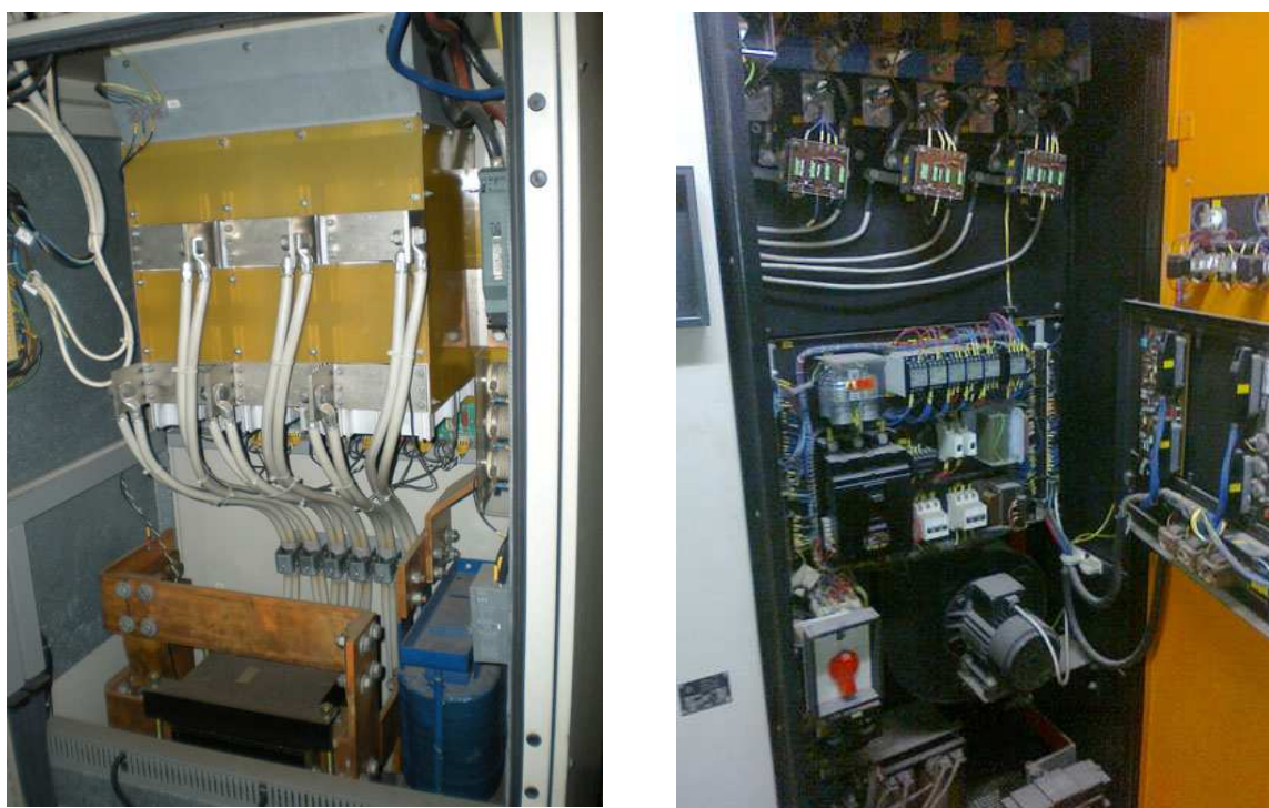
Obr. 3.3. Ukázka starých tyristorových zdrojů stále ještě hojně používaných
