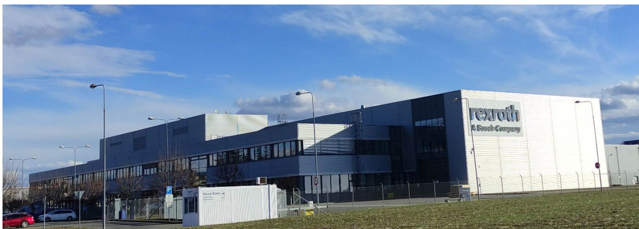
Obr. 6) Výrobní závod v Brně
