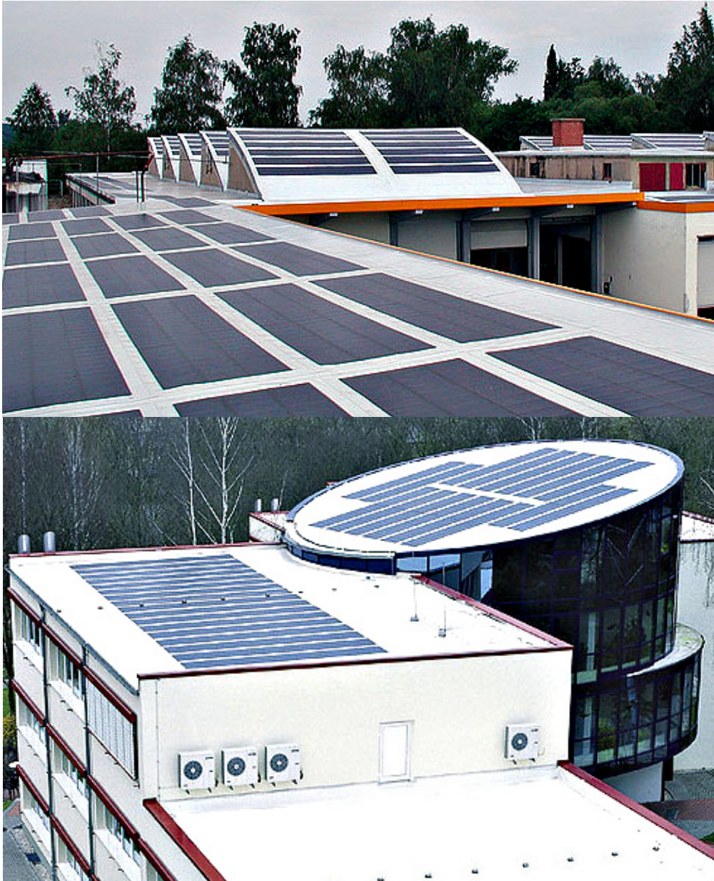
obr. 13 Ploché střechy s integrovaným fotovoltaickým systémem EVALON-Solar
