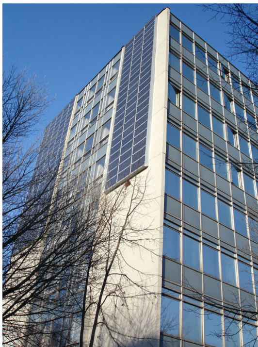
obr. 12 Budova Fakulty stavební ČVUT v Praze
