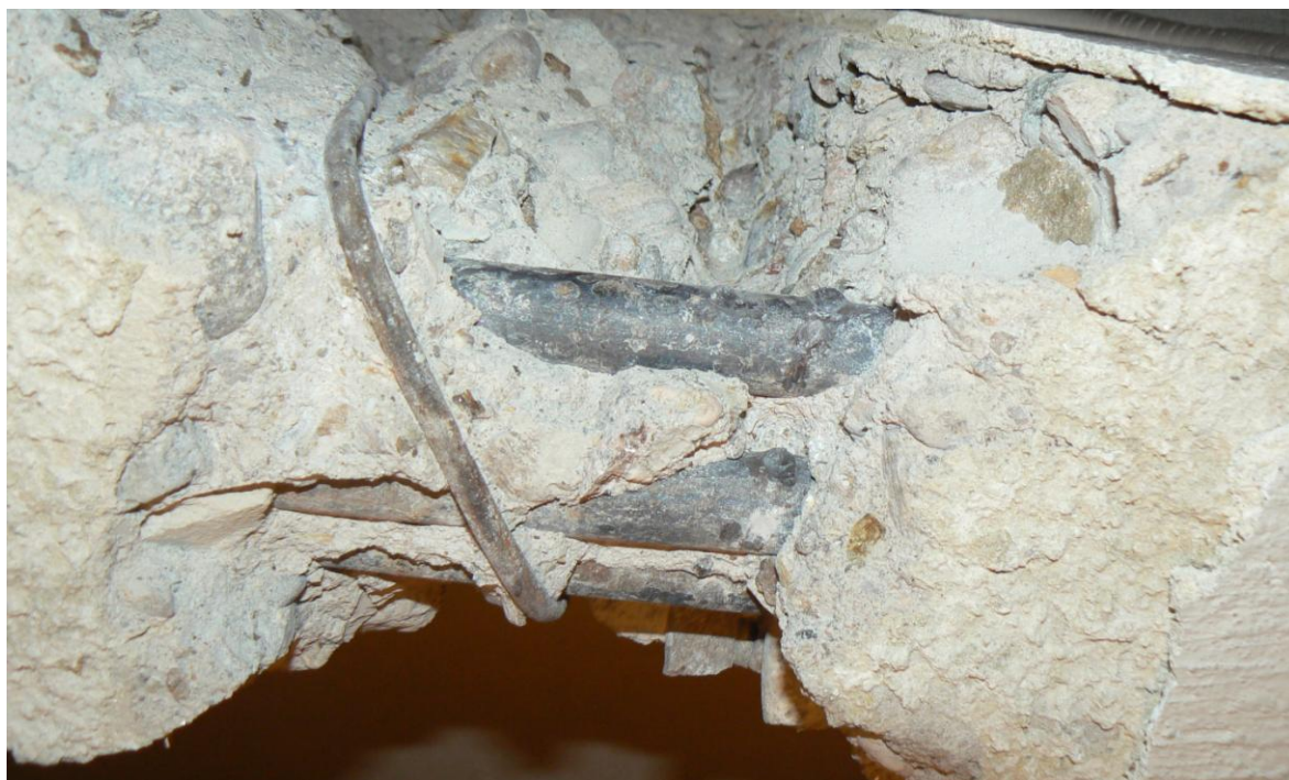
Obrázek 3.1 Ověření stavu a umístění ocelové výztuže
