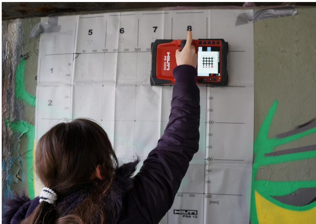
Obrázek 8.22 Pohled na provádění plošného skenu
