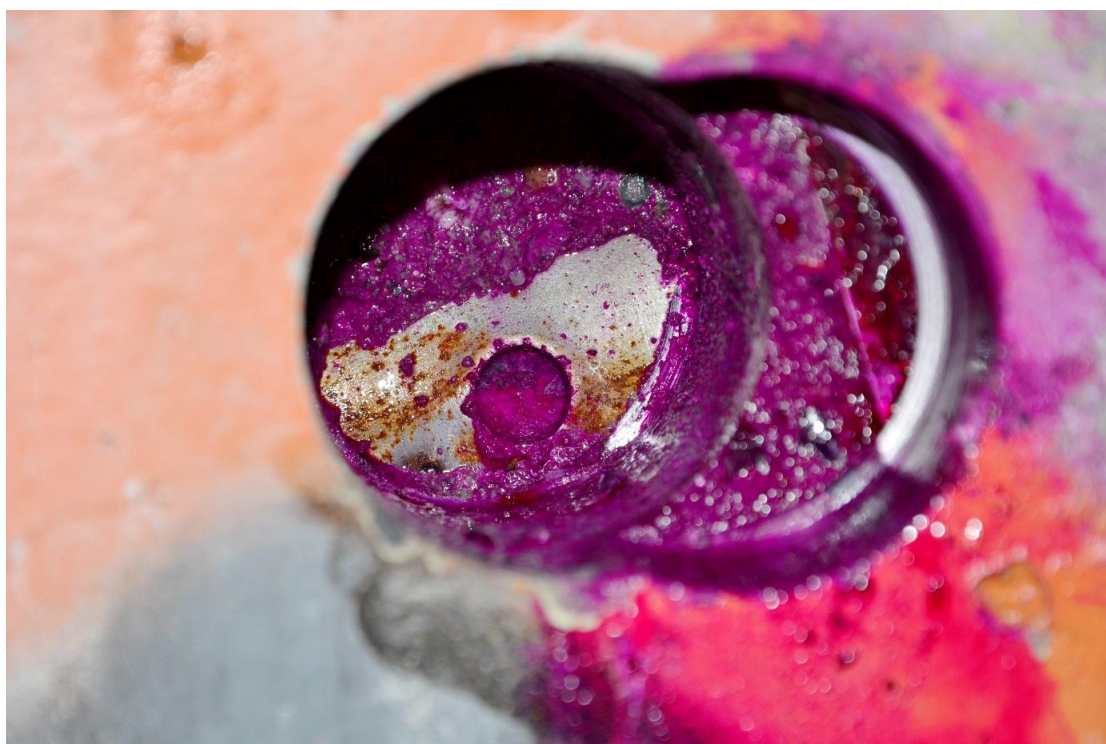
Obrázek 8.13 Sonda Z12 s patrným průrazem chráničkou kabelového kanálku a viditelnou injektážní směsí
