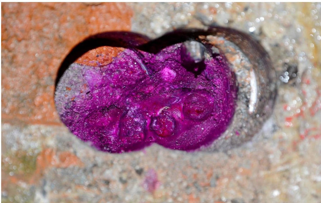
Obrázek 8.19 Sonda V12 s patrným průvrtem chráničkou kabelového kanálku a viditelnou injekční směsí
