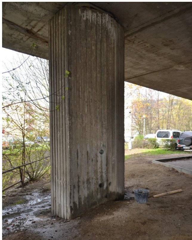
Obrázek 8.25 Celkový pohled na místo odběru vývrtu 6
