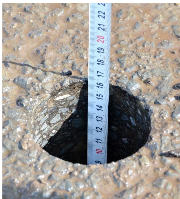
Obrázek 8.27 Ukázka sondy do vozovky
