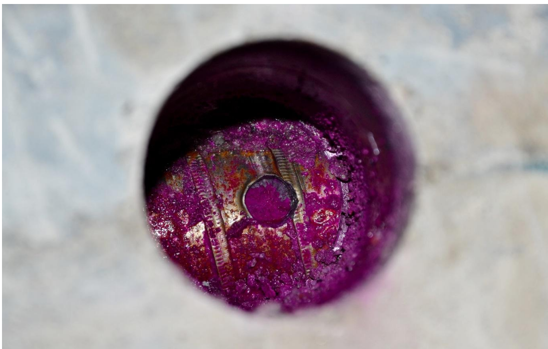
Obrázek 8.15 Sonda Z22 s patrným průřezem chráničkou kabelového kanálku a viditelnou injektážní směsí
