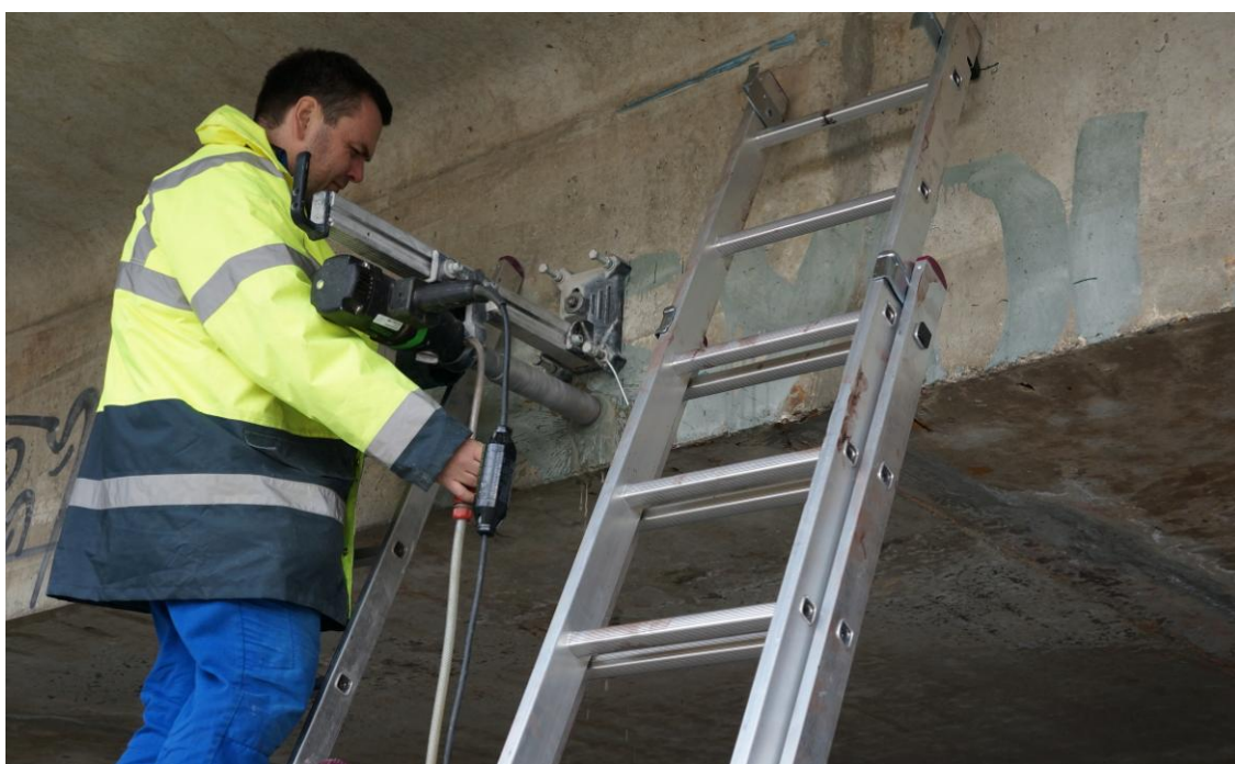
Obrázek 8.10 Celkový pohled na vývrt v místě sondy Z21
