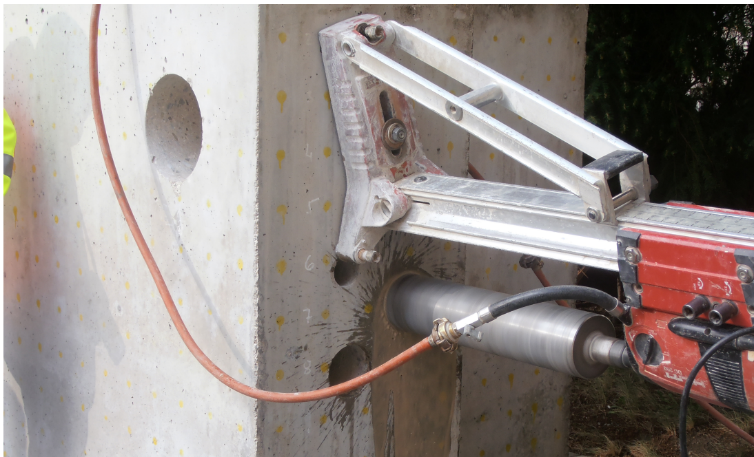
Obr. B.2: Odběr jádrového vývrtnu
