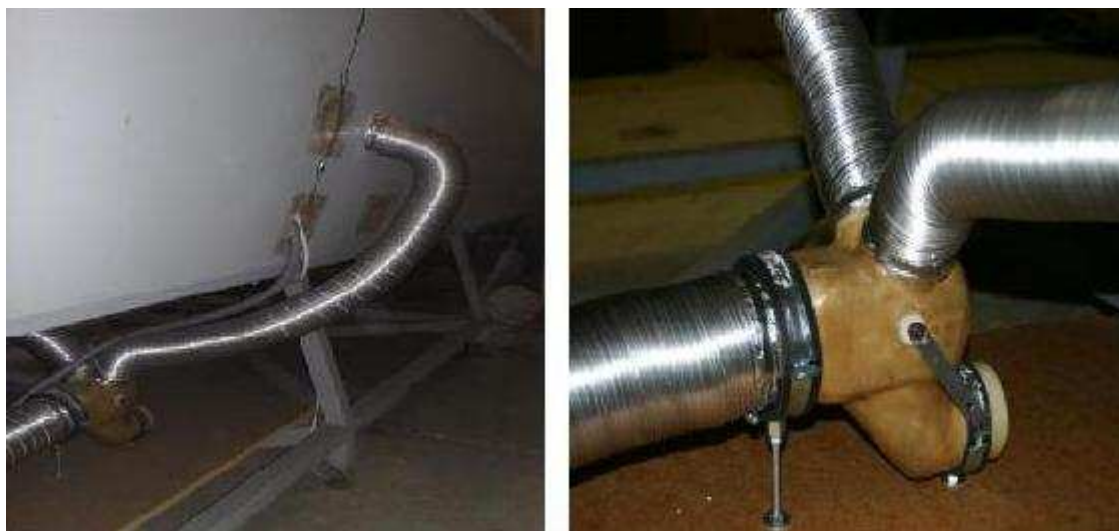
Obr. 5.5 Provedení a větvení vzduchovodů (FIŠER, 2011)
