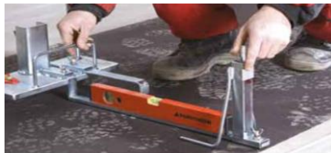
Obr. č. 3 Nastavení přípravků vyrovnávací soupravy
