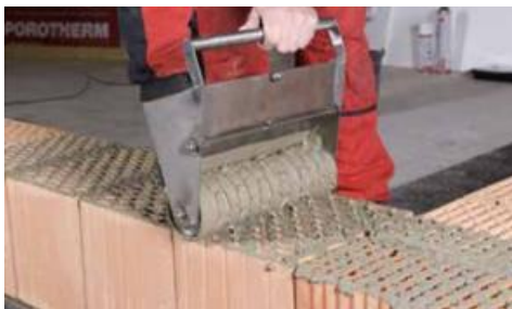
Obr. č. 5 Nanášení malty pomocí nanášecího válce
