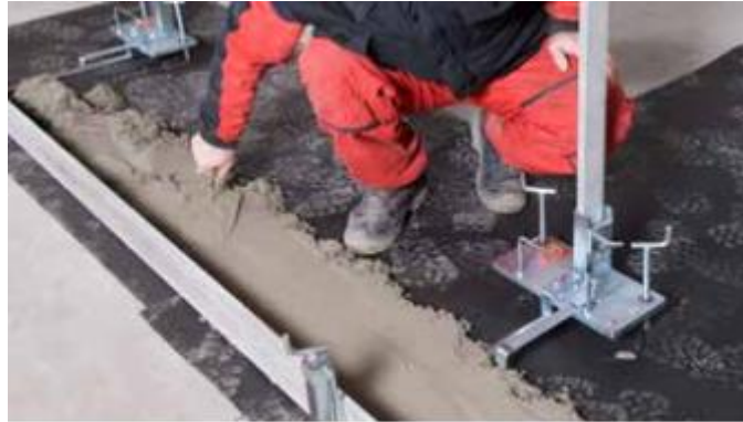
Po nanesení se zakládací malta urovná tak, že se latí malta stahuje až do úrovně vodících lišt přípravků zakládací soupravy
