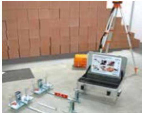
Obr. č. 2 Příprava výškového zaměření základové desky
