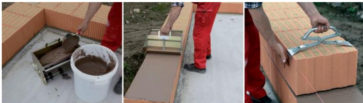
Obrázok 5.3 Spôsob nanášania malty a manipulácia s tehlyami
