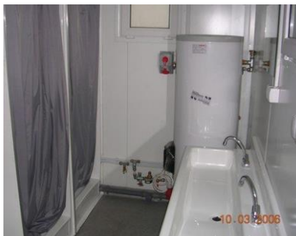
Obrázok 3.5 Kombinovaný sanitárny kontajner sprcha/wc
