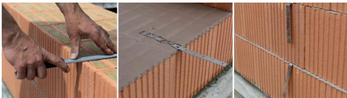
Obrázok 5.5 Osadenie oceľových spôn k napojeniu stien (tupý spoj)
