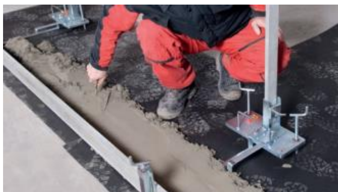
Obrázok 5.1 Vyrovnávací súprava pre nanesenie malty
