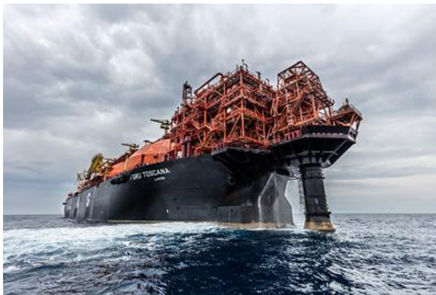
Obr. 4.3 Terminál pro přijímání kapalného zemního plynu v Itálii[33]
