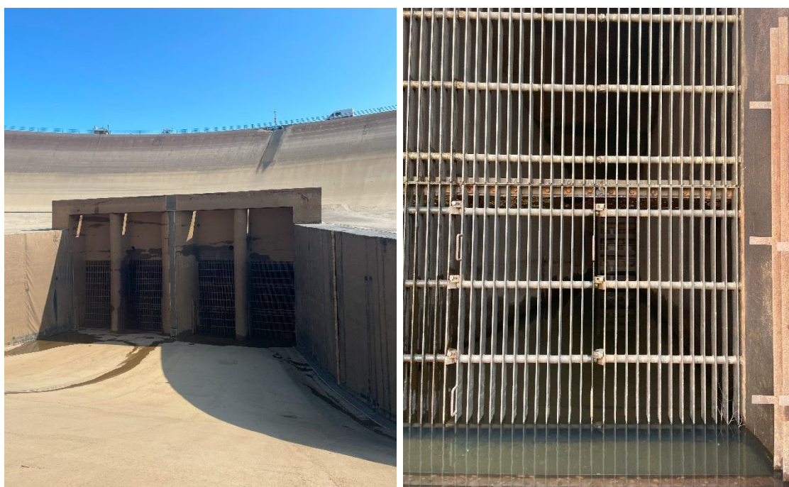
Obr. 2.9: Vana vtokového objektu (vlevo) a česle na nátoku do přivaděče (vpravo)
