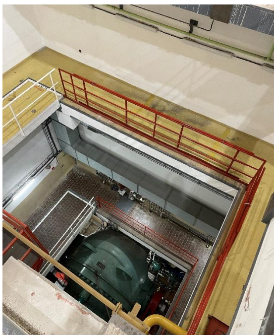
Obr. 5.3: Kulový uzávěr tlakového přivaděče
