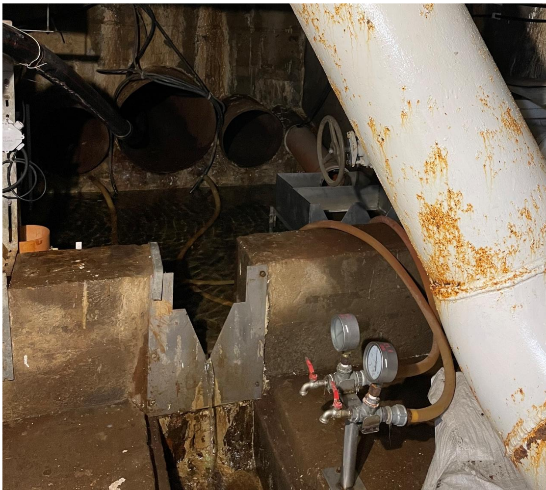
Obr. 2.4: Sběrná jímka průsaků při běžném provozu (květen 2024)
