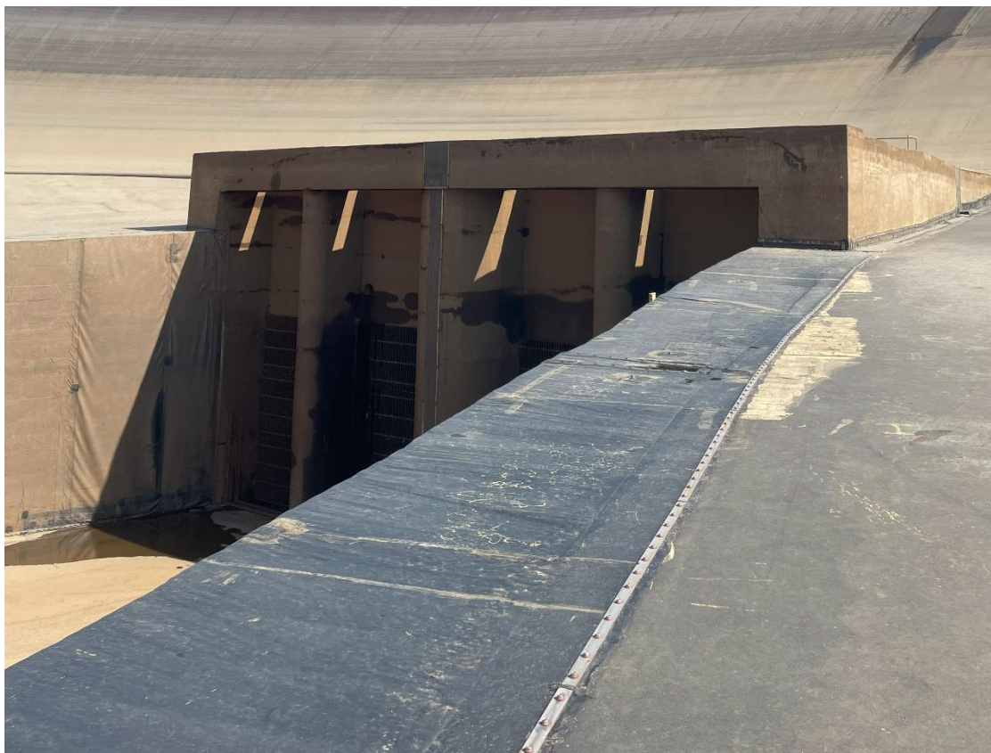
Obr. 2.10: Těsnění vtokového objektu po provedené rekonstrukci
