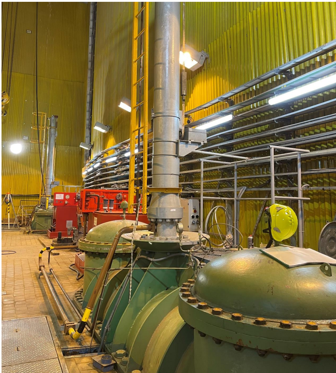
Obr. 2.11: Pohled na ovládání skříňových uzávěrů tlakových přivaděčů
