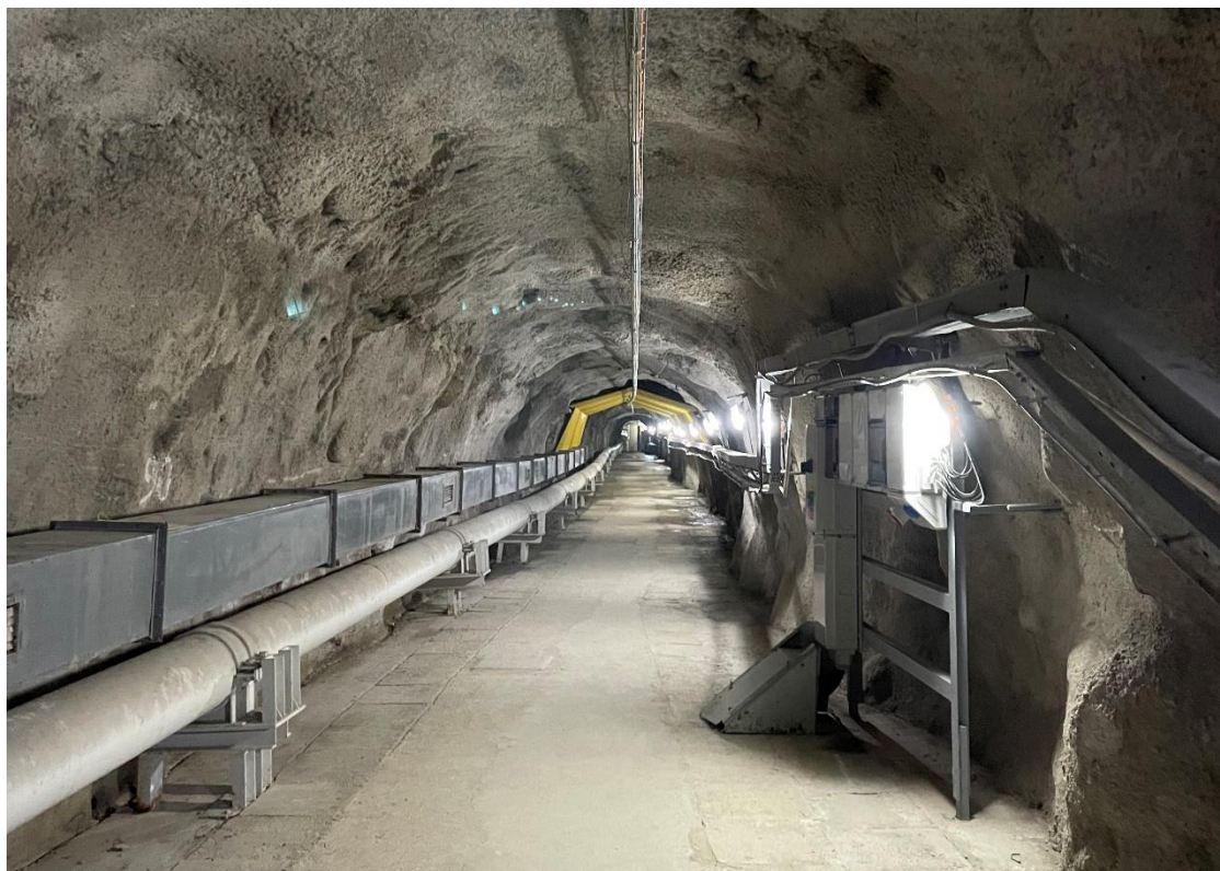
Obr. 2.13: Prostor přístupové štoly v tělese hráze horní nádrže
