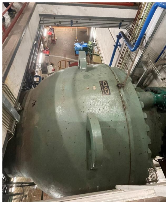
Obr. 5.3: Kulový uzávěr tlakového přivaděče
