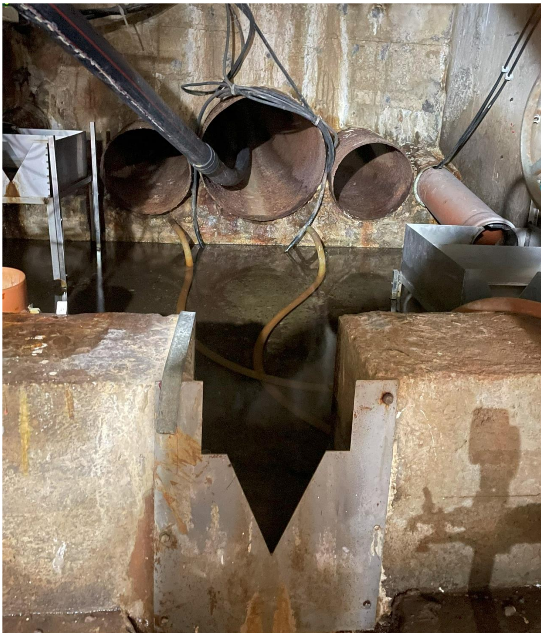
Obr. 2.3: Sběrná jímka průsaků při vypuštěné nádrži (srpen 2024)
