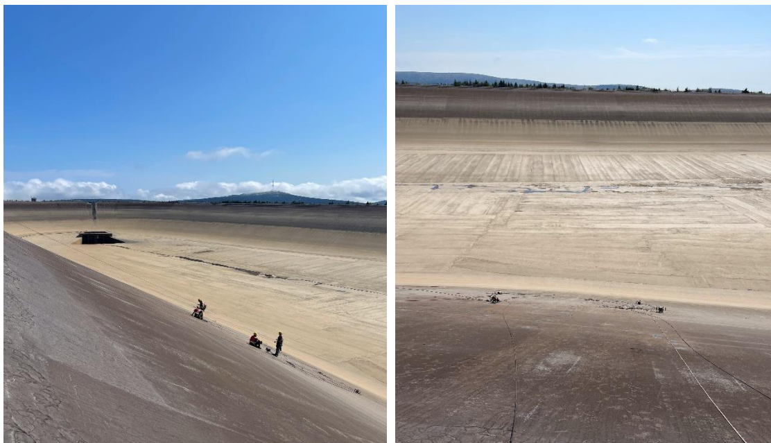
Obr. 2.4: Jištění pracovníků (vlevo) a jejich nástrojů (vpravo) pomocí lan
