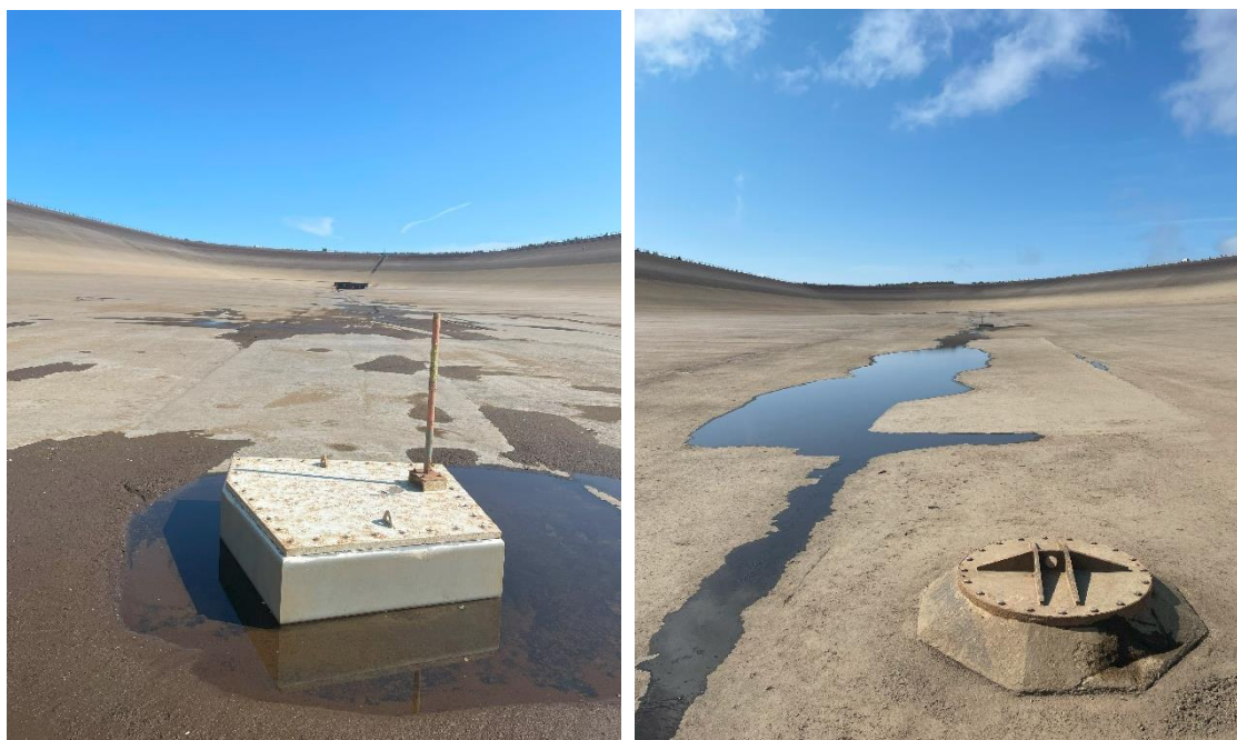
Obr. 2.5: Šachta páteřního drénu Š1 (vlevo) a Š2 (vpravo)
