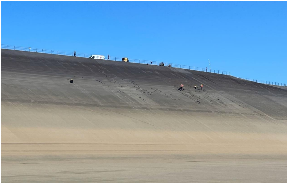
Obr. 2.3: Průběžné opravy lokálních poruch asfaltobetonového pláště
