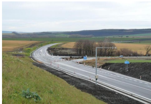
Obrázek 2: I/50 Bánov, obchvat Zdroj: zpracováno na základě zdroje (16)
