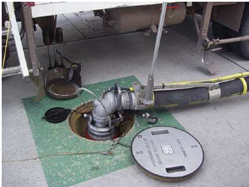
Obrázek 18: hydrantový systém plnění paliva [20]
