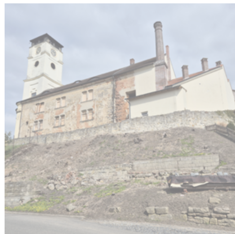
pohled z ulice Tyršova
