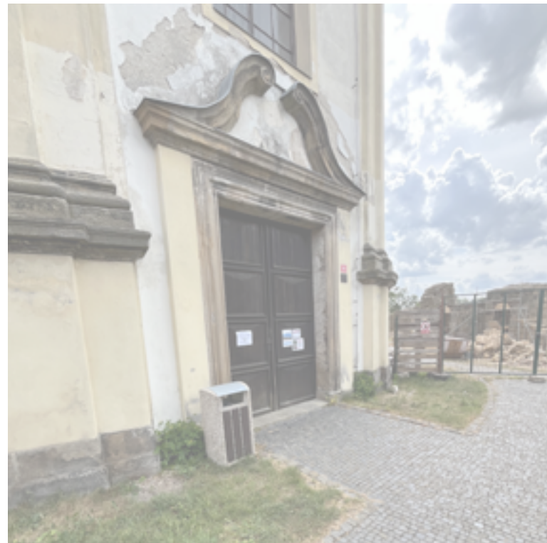
vtup na Vyhlídkovou věž
