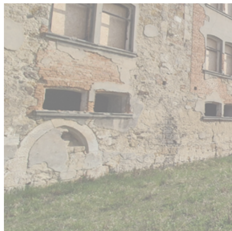
zabezpečení okenních otvorů a zazděný gotický oblouk
