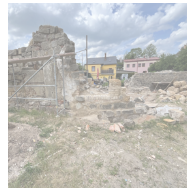
oprava bývalá kaple
