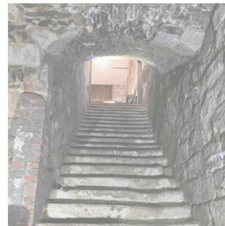
schodiště do podzemí
