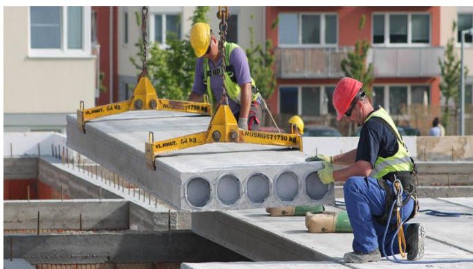
Obr. 4.1 Osazení panelu pomocí samosvorných kleští[2]
