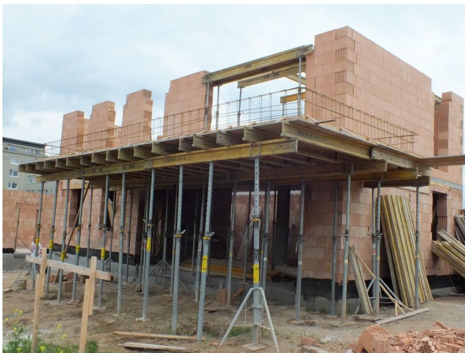
Obrázek 7- Betonová konstrukce (betonstropy; 2015)
