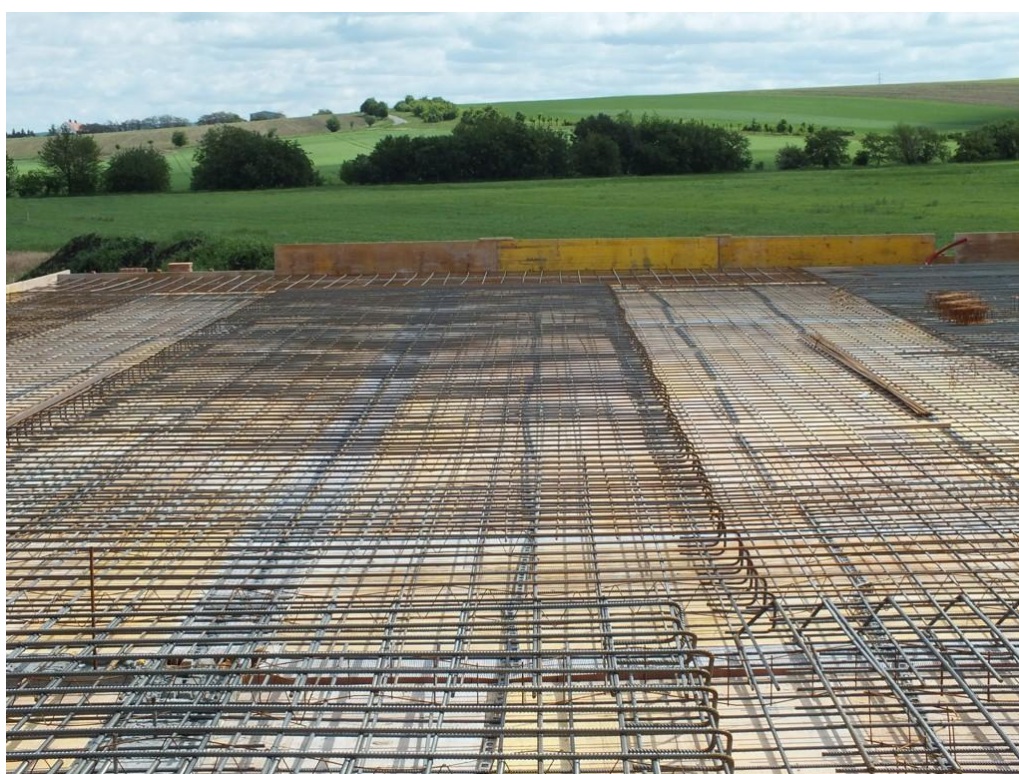
Obrázek 8- Betonová konstrukce (betonstropy; 2016)
