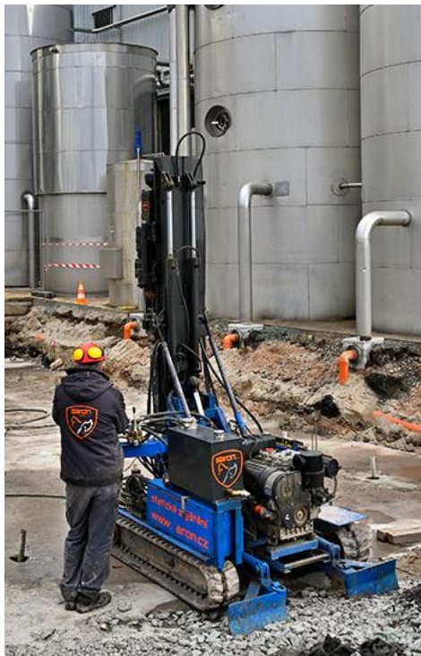
Obr.36, Mikropilotová vrtná souprava RC195Y https://mikropilotaz.cz/
