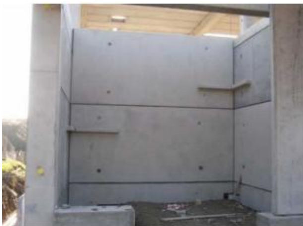
Obr. 1. 6 - Schodišťové stěny
