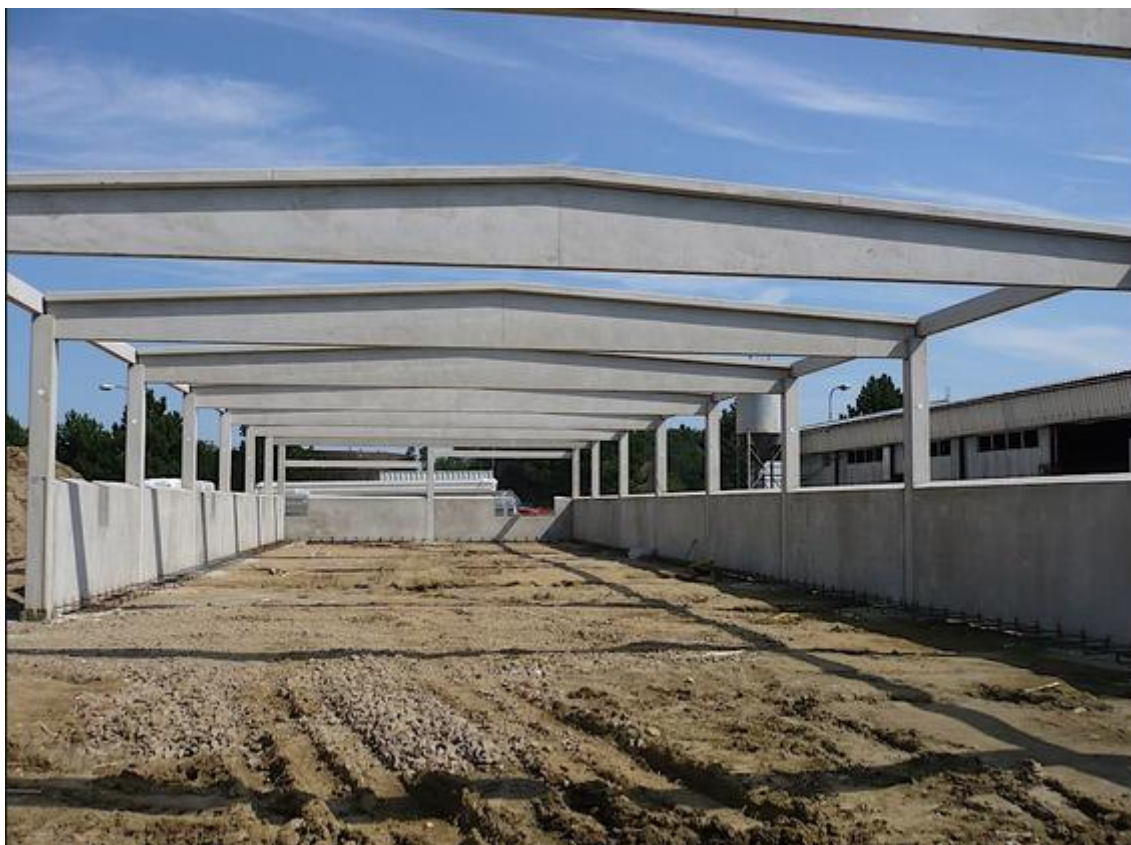
Obr. 1. 3 - Montáž vazníků
