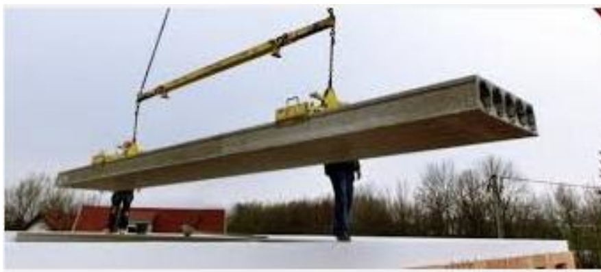
Obr. 1. 8 - Osazení panelů spiroll
