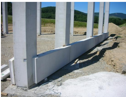
Obr. 1. 2 - Montáž základových prahů
