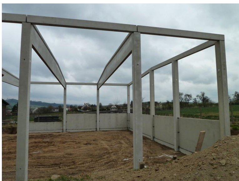
Obr. 1. 5 - Osazené parapetní panely
