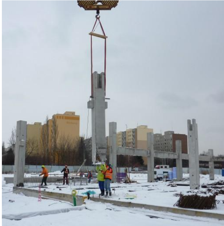
Obr. 1. 1 - Montáž sloupů
