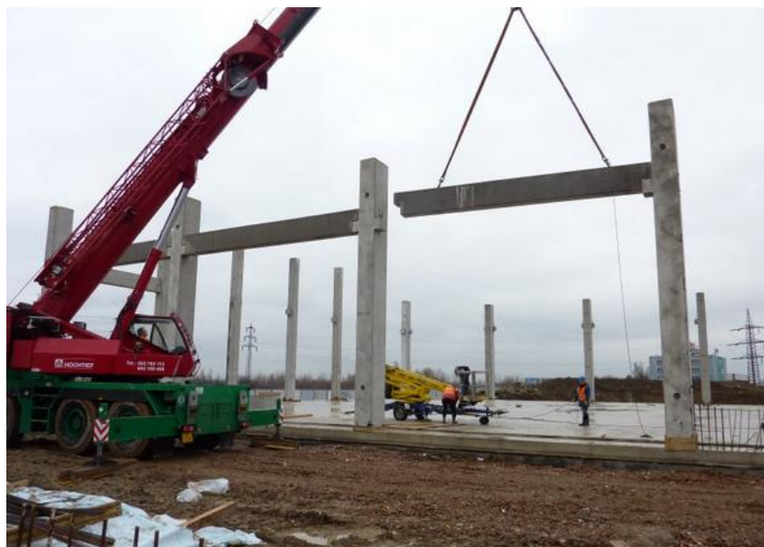
Obr. 1. 7 - Osazení průvlaků
