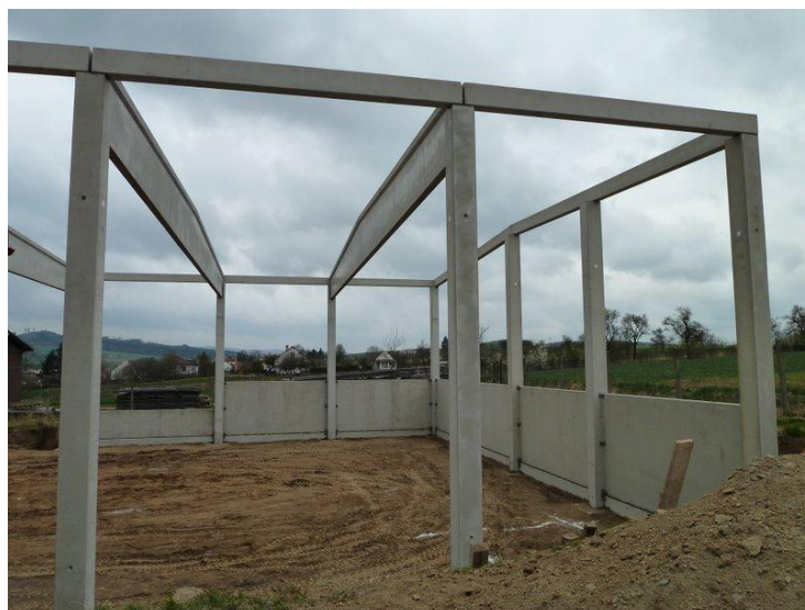
Obr. 1. 4 - Osazená ztužidla
