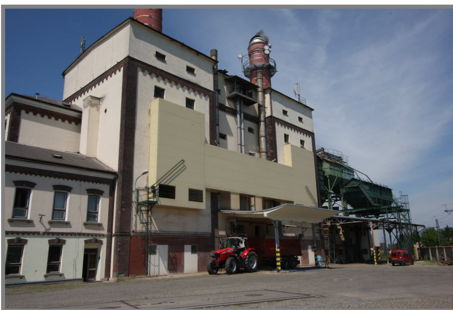
Obr. 1.13 Pohled na budovu sušení, sladovna Brodek u Přerova
