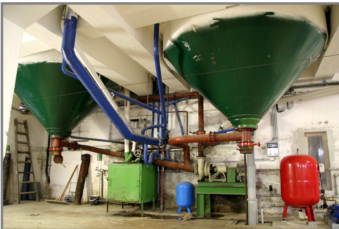
Obr. 1.3 Pohled na spodní část náduvníku, sladovna Mšeno
