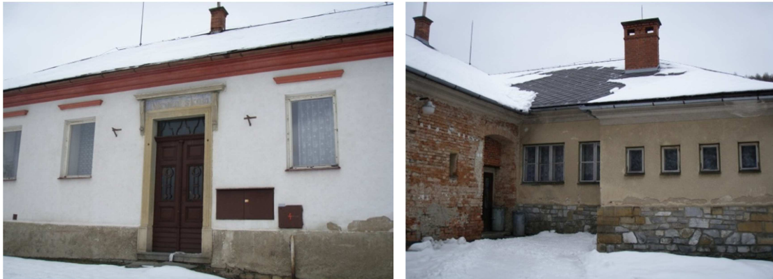
Obr. 3.1. Objekt polyfunkčního domu – nová část a stará část
