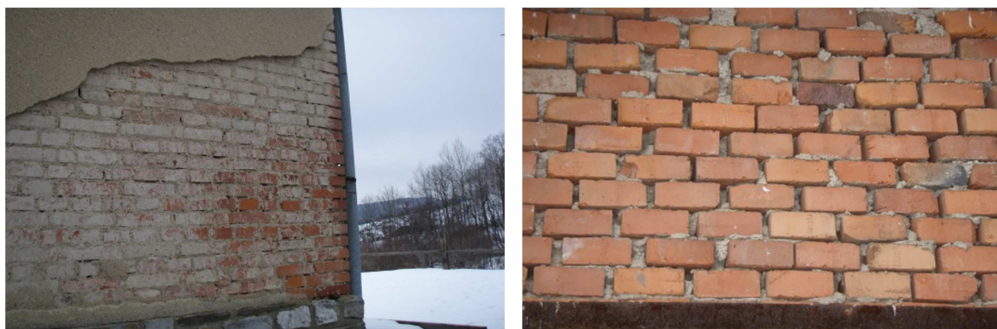
Obr. 3.2 Venkovní omítky a provedení dodatečně vyzděných konstrukcí
