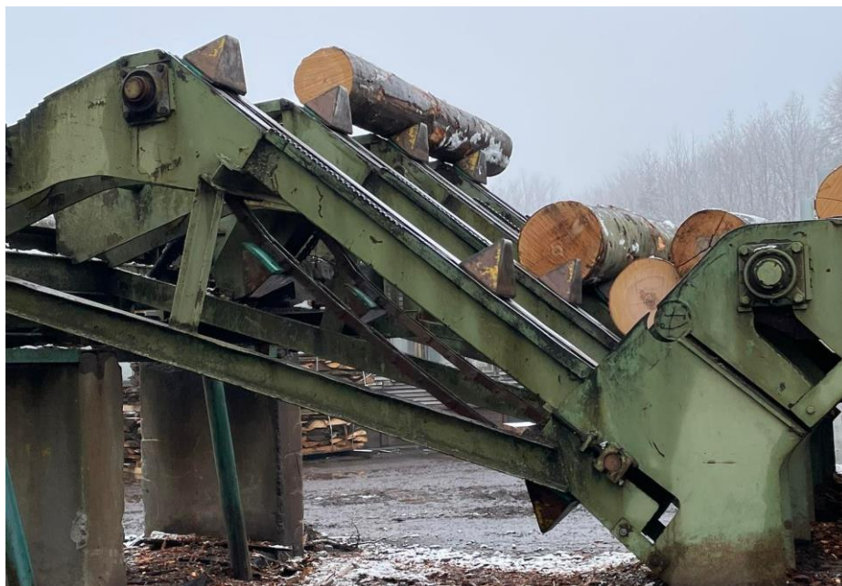
Obr. 8 Rozjednovací dopravník [Pila Olomučany, 2023]
