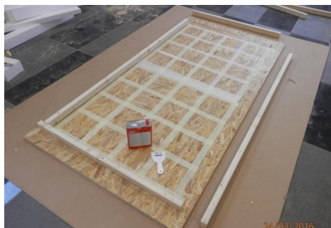
Obr. 23: První vrstva připravená k lepení
