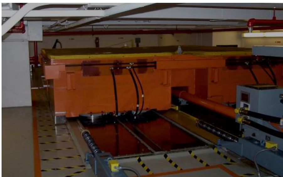
Obrázek 22: Dynamický tlumič vibrací mrakodrapu John Hancock Tower. Převzato z [32]
