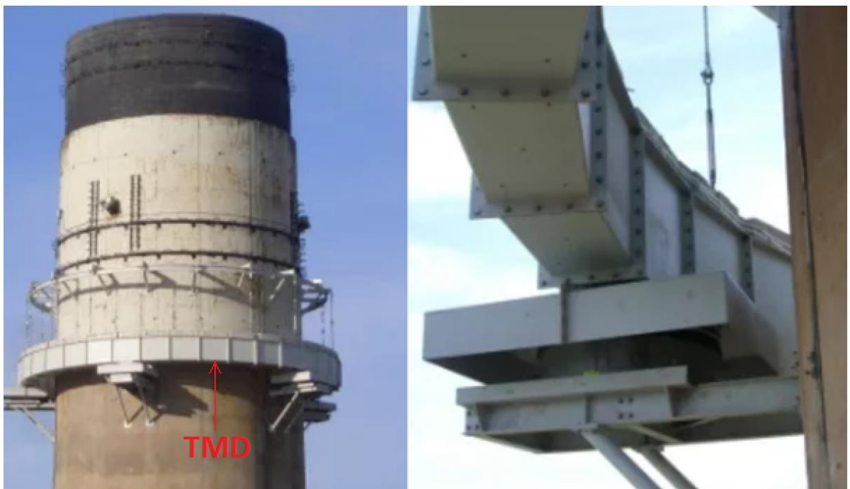
Obrázek 26: TMD na 180 metrů vysokém komíně. Převzato z [21]
