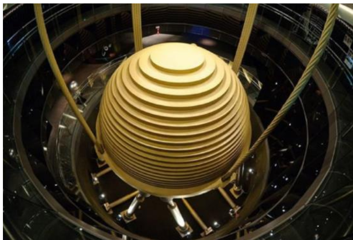
Obrázek 21: Dynamický tlumič vibrací mrakodrapu Taipei 101. Převzato z [31]
