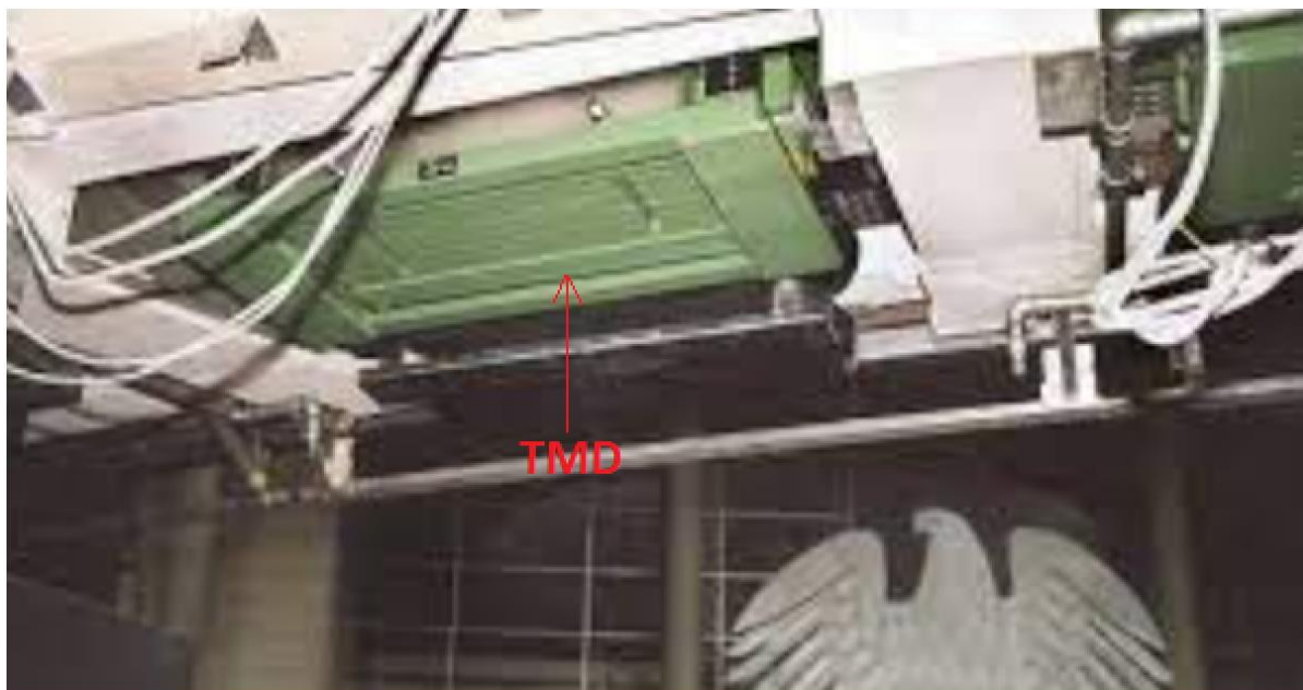
Obrázek 34: Tribuna pro diváky s dynamickým tlumičem vibrací. Převzato z [36]
