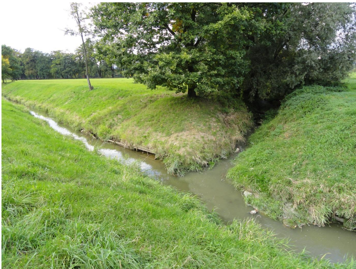
Obr. 6.16. Zaústění rybníka, ř.km 0,510 [21]
