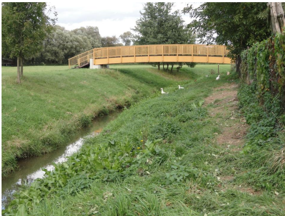
Obr. 6.15. Lávka pro pěší, ř.km 0,702 [21]
