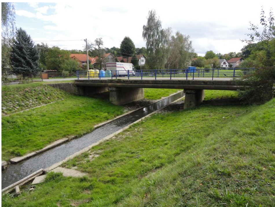
Obr. 6.5. Silniční most v ř.km 2,587 (P44) [21]
