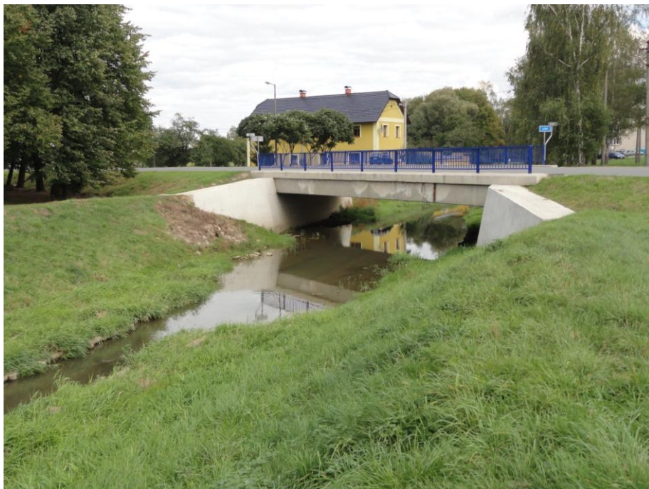
Obr. 6.13. Betonový silniční most v ř.km 1,294 (P21) [21]
