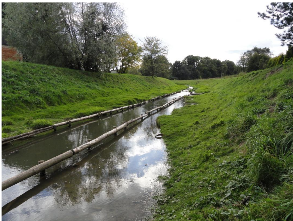
Obr. 6.4. Obnažené opevnění kynety [21]
