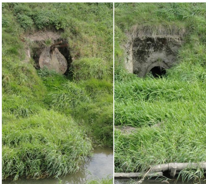
Obr. 6.7. Potrubí zaústěna do koryta Luhy [21]
