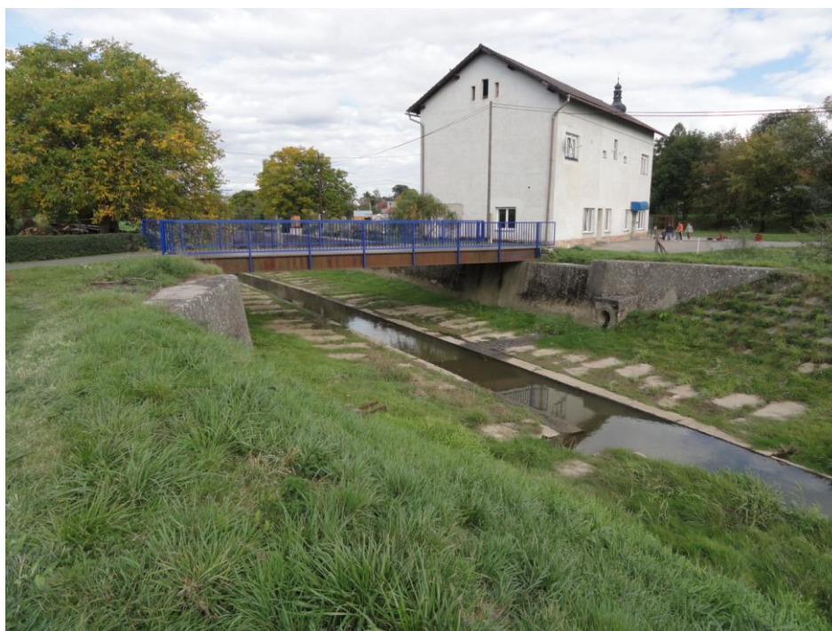
Obr. 6.8. Ocelový cestní most ř.km 2,036 (P34) [21]
