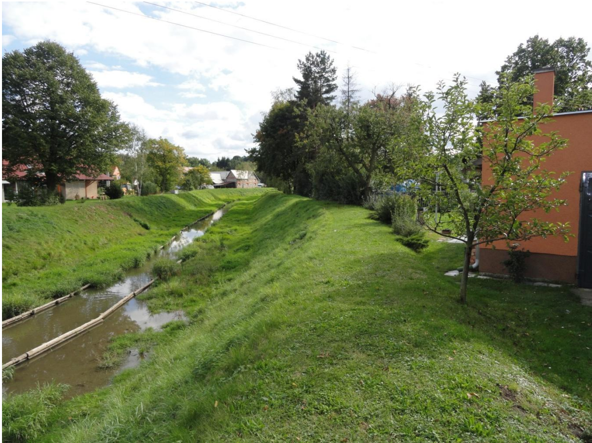
Obr. 6.6. Ohrazování je v těsné blízkosti obytných domů [21]
