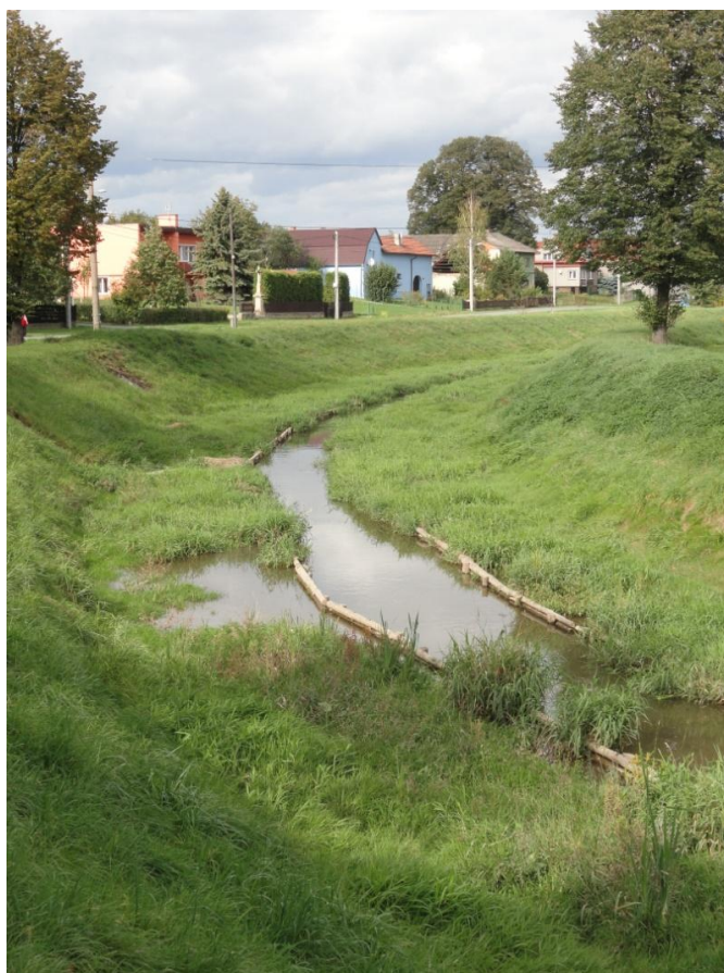
Obr. 6.3. Zamokření berem [21]
