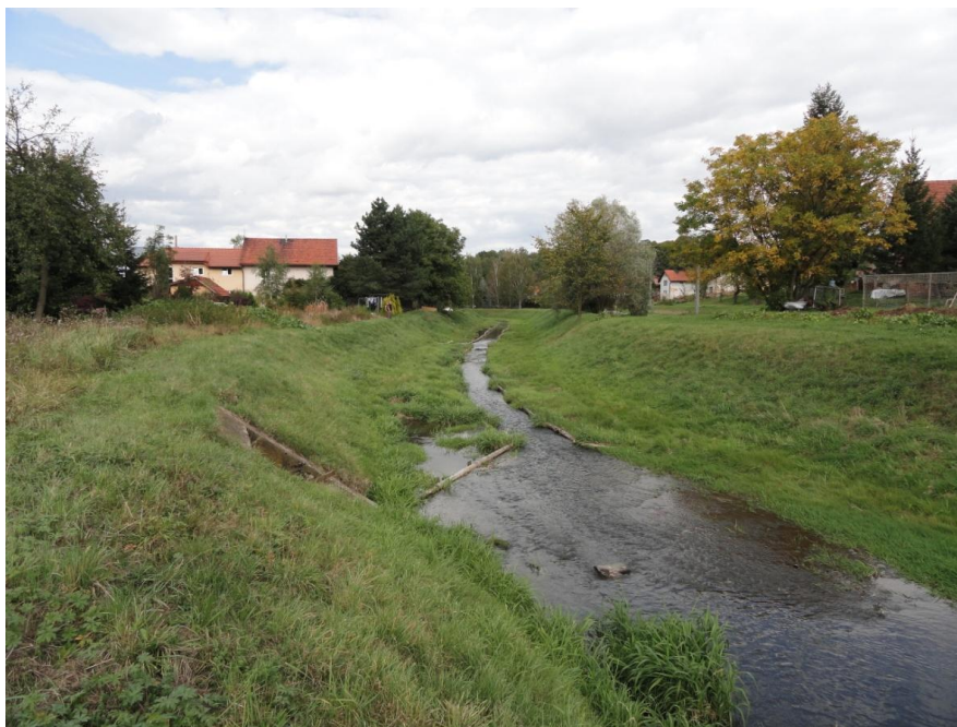
Obr. 6.1. Konec úpravy, ř.km 2,850 [21]
