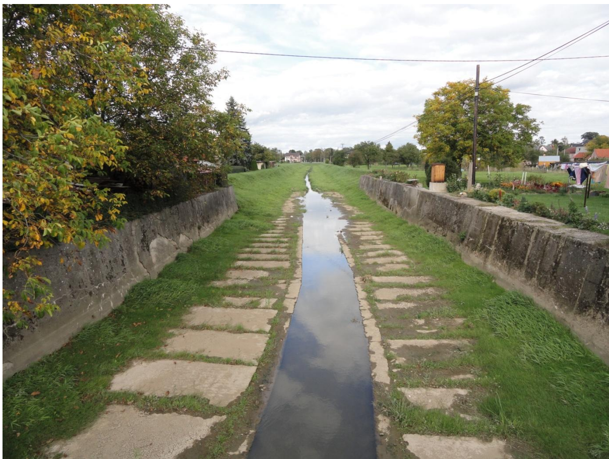
Obr. 6.9. Obdélníkový tvar koryta za cestním mostem v ř.km 2,036 [21]
