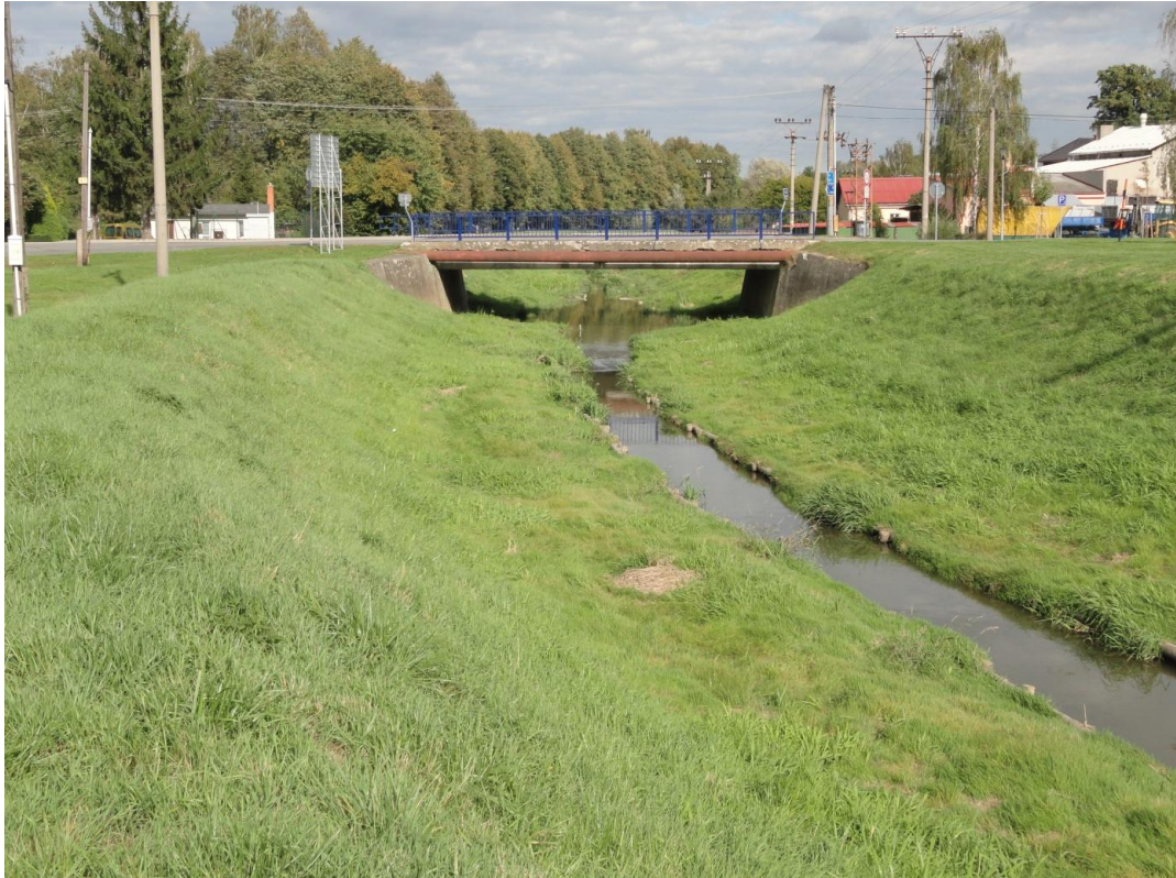
Obr. 6.10. Betonový silniční most v ř.km 1,593 (P26) [21]
