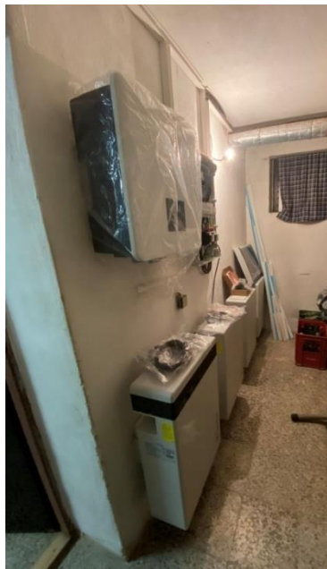
Obrázek 31: Technická místnost při instalaci technologie
