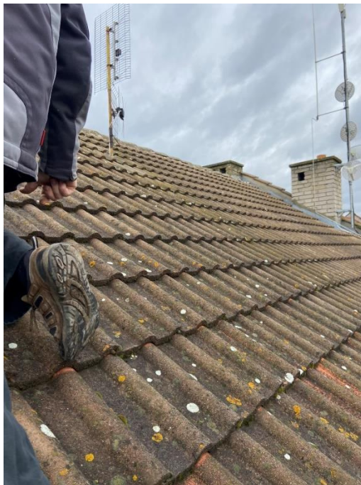
Obrázek 40: Střecha před instalací fotovoltaických panelů
