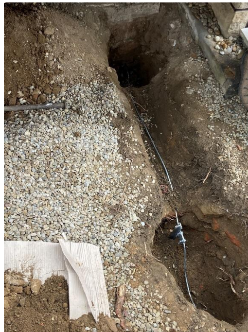
Obrázek 35: Napojení zemnicího drátu k zemnicím tyčím
