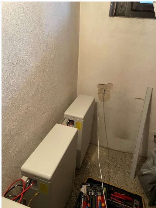
Obrázek 34: Vyvedení drátu FeZn k zemnicím tyčím
