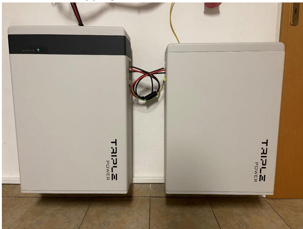
Obrázek 15: Master/Slave battery SolaX
