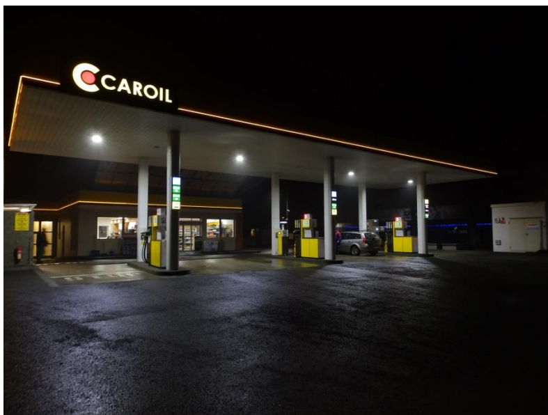
Obr. 17: Čerpací stanice CAROIL 81 .
