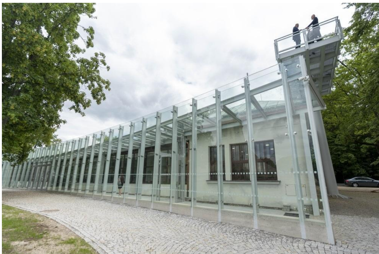
Obrázek č. 4 – Návštěvnické centrum Mohyla Míru, Prace[37]
