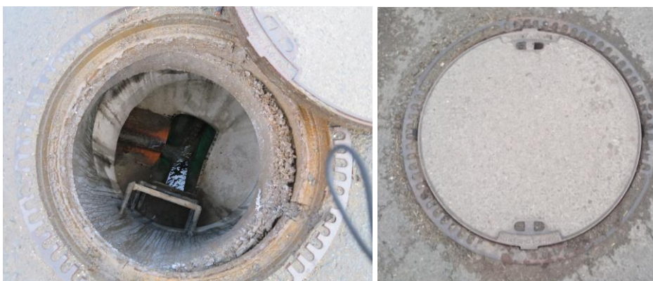
Obrázek 6-58 Šachta Š 44 [zdroj: Čagášek]
