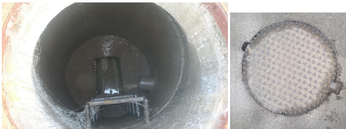
Obrázek 6-62 Šachta Š 40 [zdroj: Čagášek]
