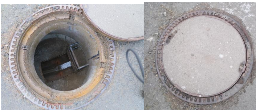
Obrázek 6-60 Šachta Š 42 [zdroj: Čagášek]
