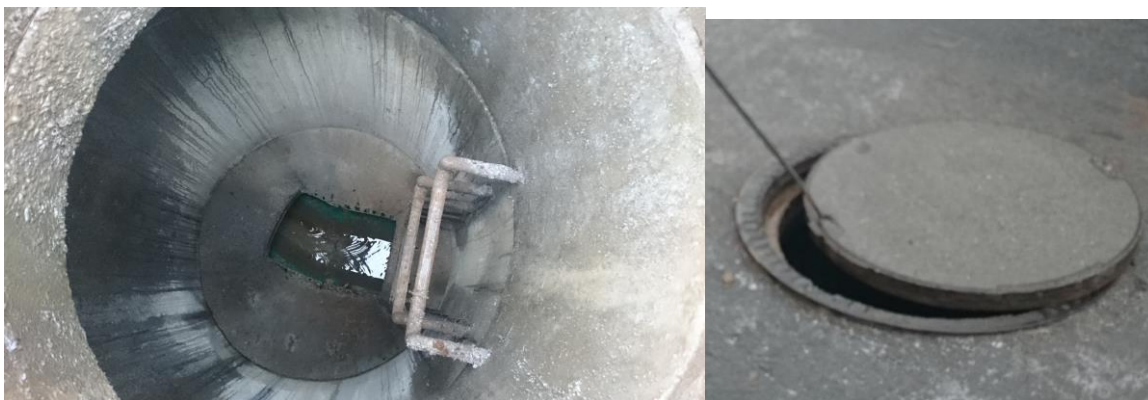
Obrázek 6-65 Šachta Š 37 [zdroj: Čagášek]
