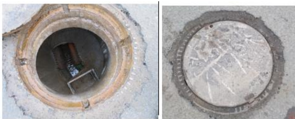
Obrázek 6-59 Šachta Š 43 [zdroj: Čagášek]
