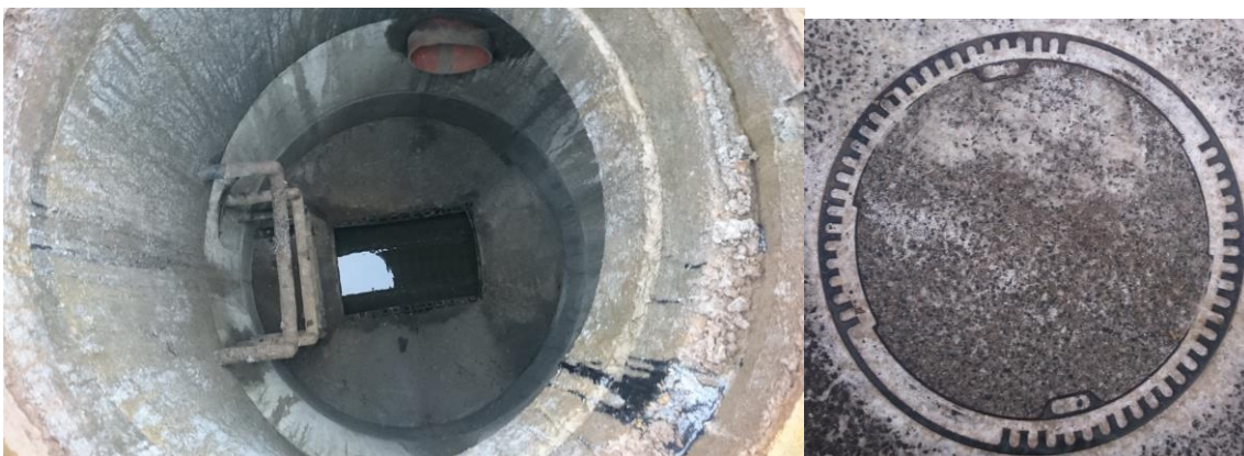
Obrázek 6-64 Šachta Š 38 [zdroj: Čagášek]
