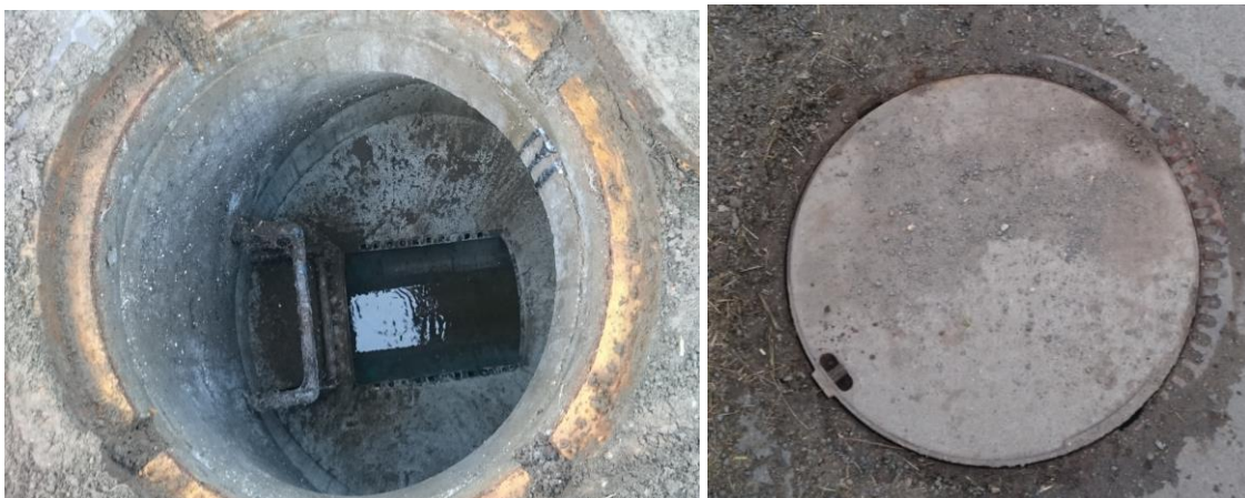
Obrázek 6-61 Šachta Š 41 [zdroj: Čagášek]
