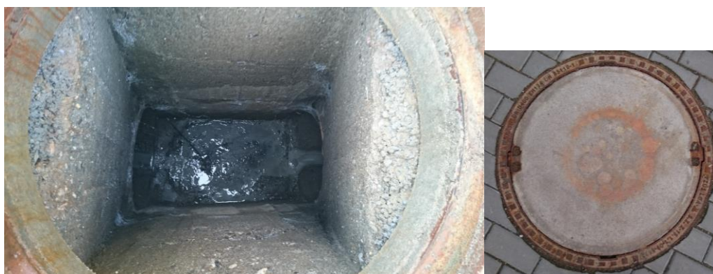
Obrázek 6-68 Šachta Ša29 [zdroj: Čagášek]
