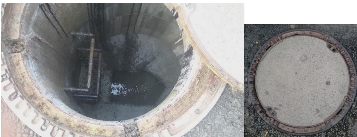
Obrázek 6-63 Šachta Š 39 [zdroj: Čagášek]
