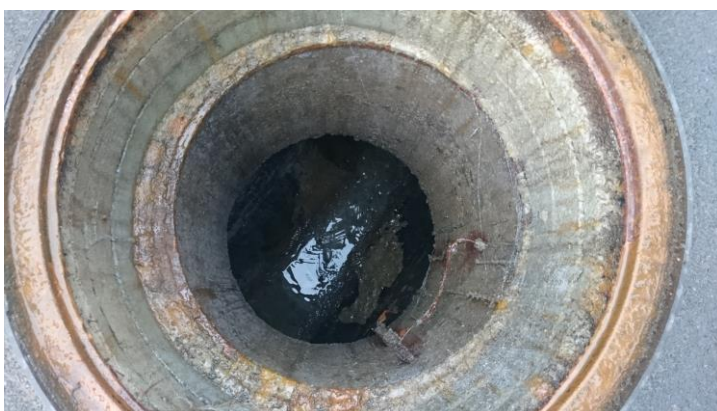
Obrázek 6-66 Šachta 113 [zdroj: Čagášek]
