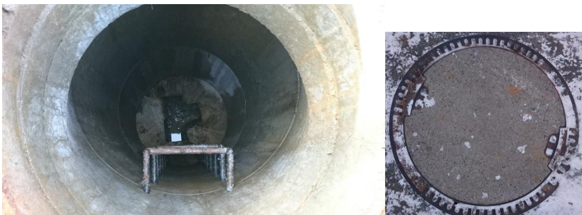
Obrázek 6-69 Šachta Ša80 [zdroj: Čagášek]
