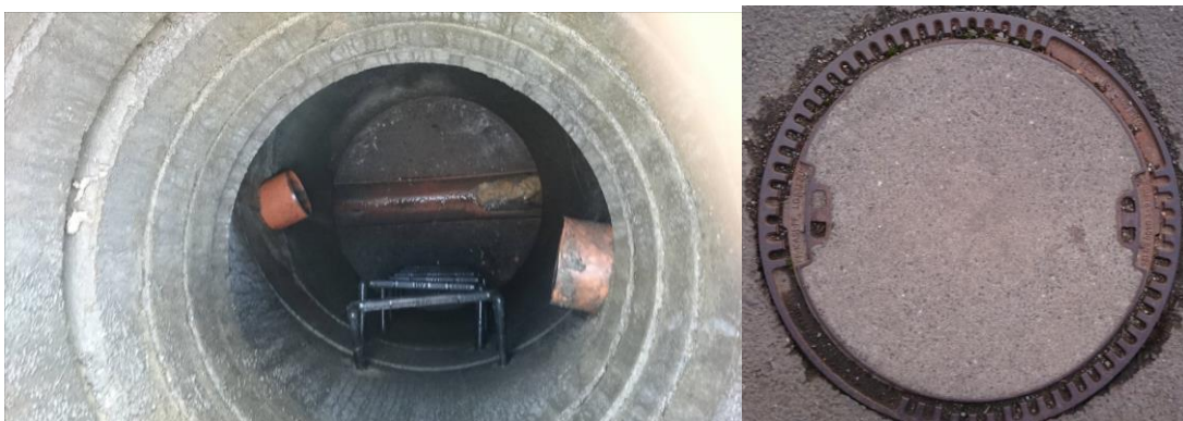
Obrázek 6-70 Šachta Ša51 [zdroj: Čagášek]
