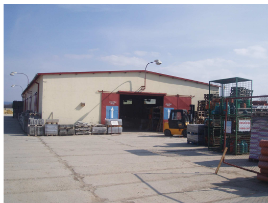
Obrázek 3 - Skladovací hala (Zdroj: Vlastní)
